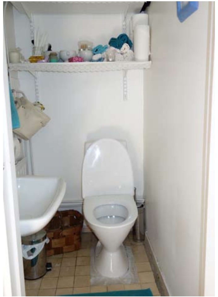
Tontti 36 Rakennus R1 olemassaoleva märkätilat
