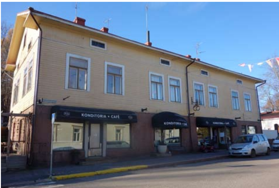
Tontti 37, päärakennus R5 nykyasussaan
