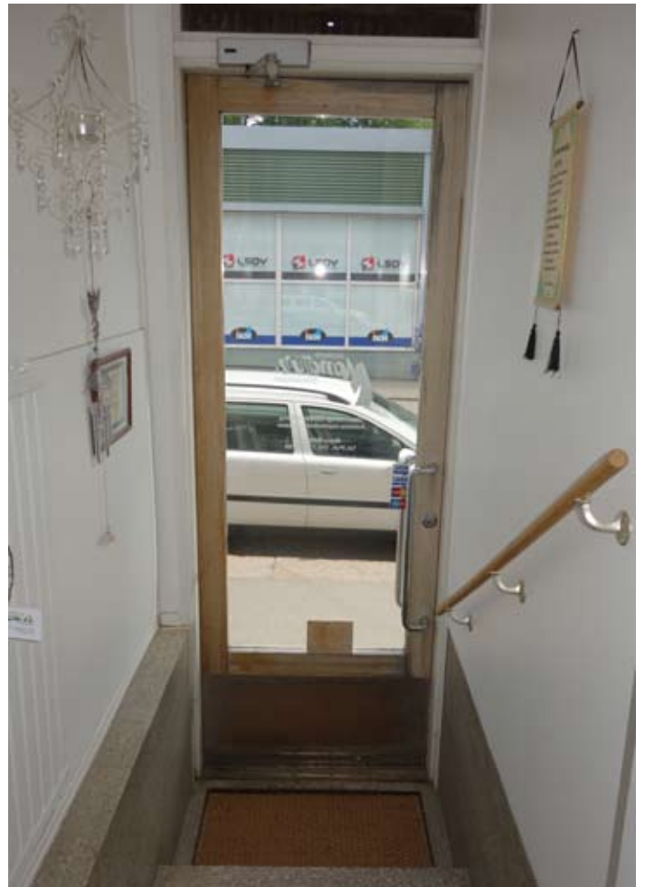
Tontti 36 Rakennus R1 näkymä liiketilasta
