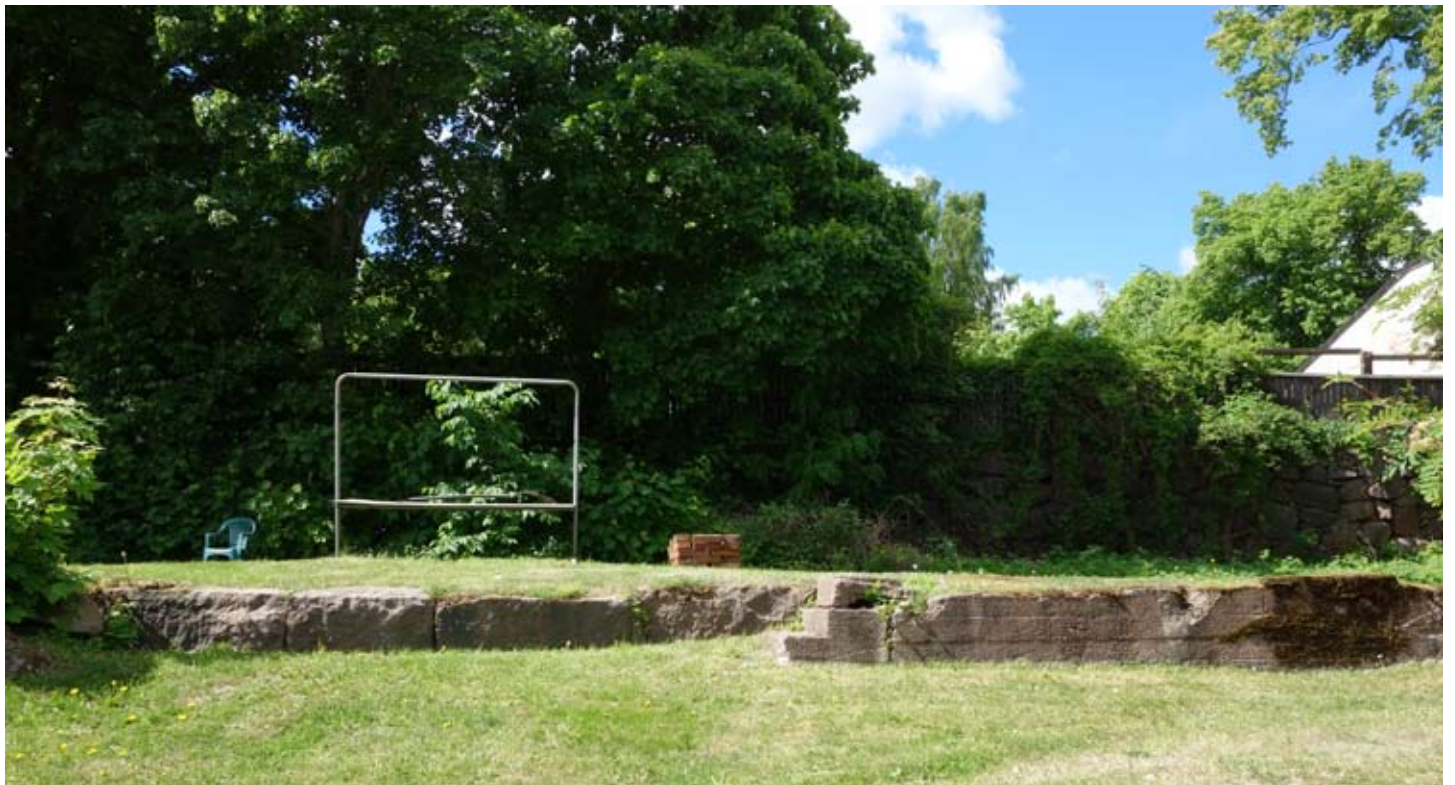
Rakennus R8 kivijalka pihamaalla.
