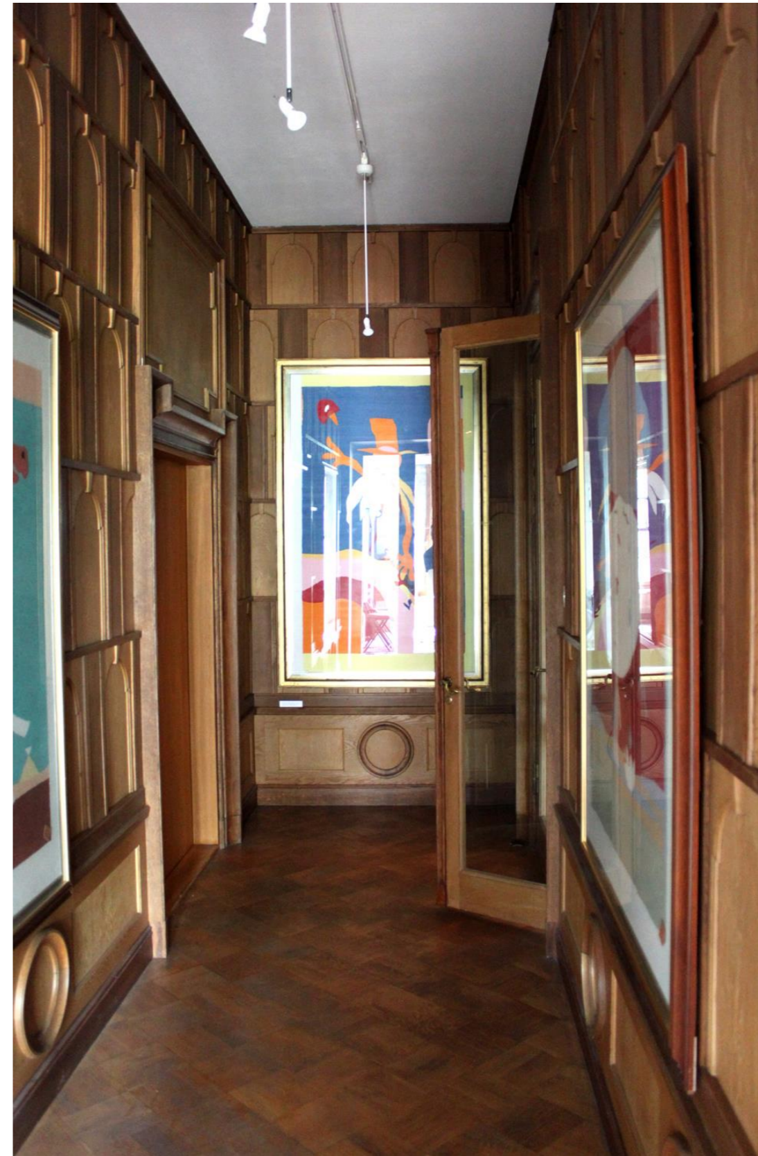
Kuva 23. Näkymä talvipuutarhasta käytävään, joka on alun perin ollut osa vasemmalle jäävää salia. Muutostöiden ohessa rakennettu käytävä on verhottu salista siirrettyin puuverhouksin. Oikealle jää pääportaikko.
