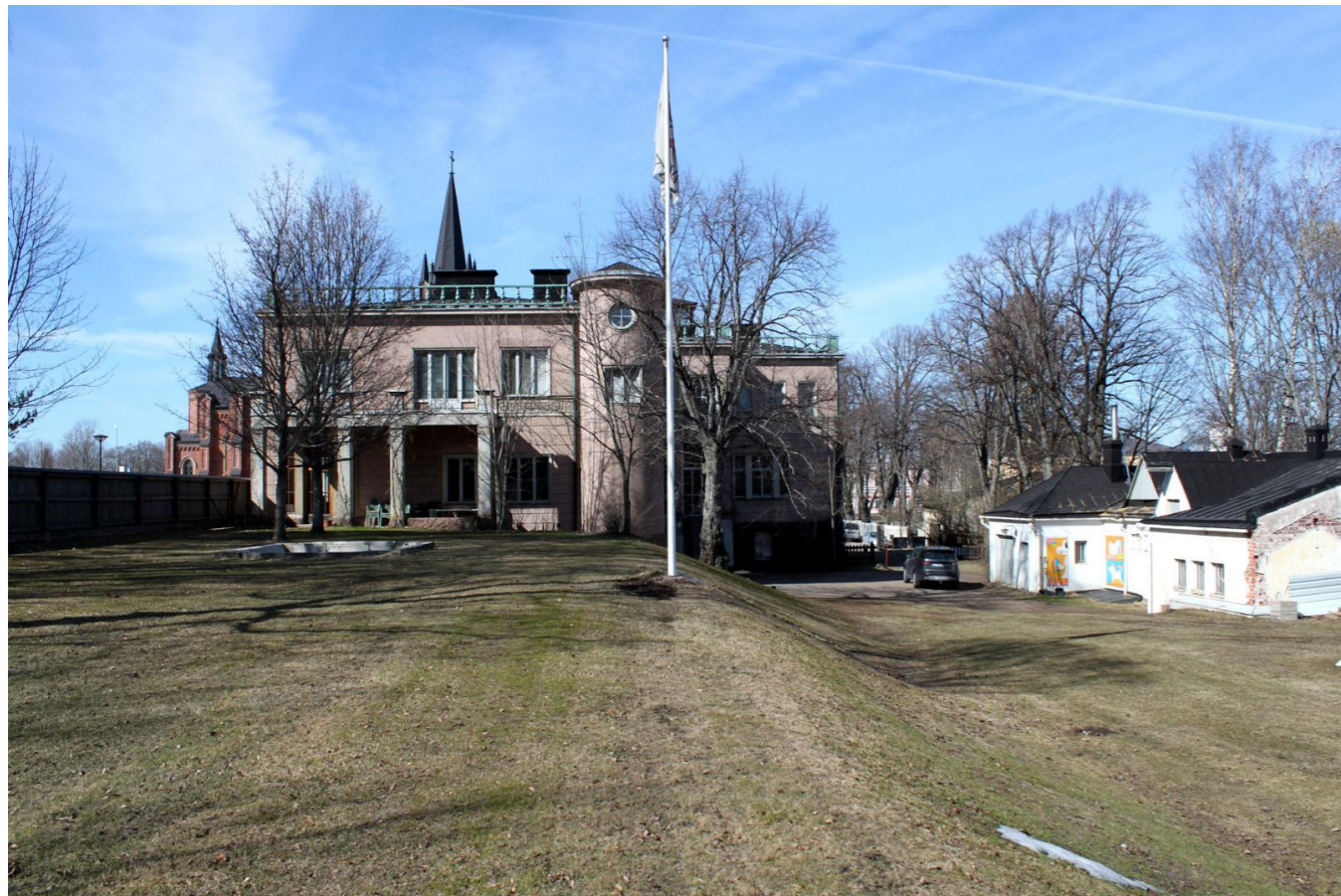
Kuva 32. Kuva pihalta, oikealla piharakennus.
