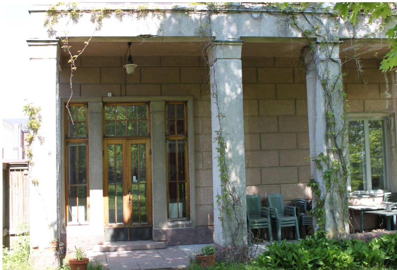
Kuva 29. Pihan puolen parvekkeen alla on tammiovi ja ikkunat sekä alumiinipintainen ikkuna.
