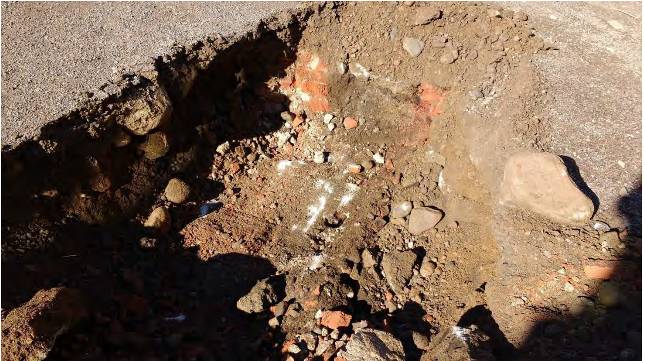
Kuva 3. Koekuopan KK3 pohjoisreunassa todettiin tiilirakenne ja pohjalla betonia.
