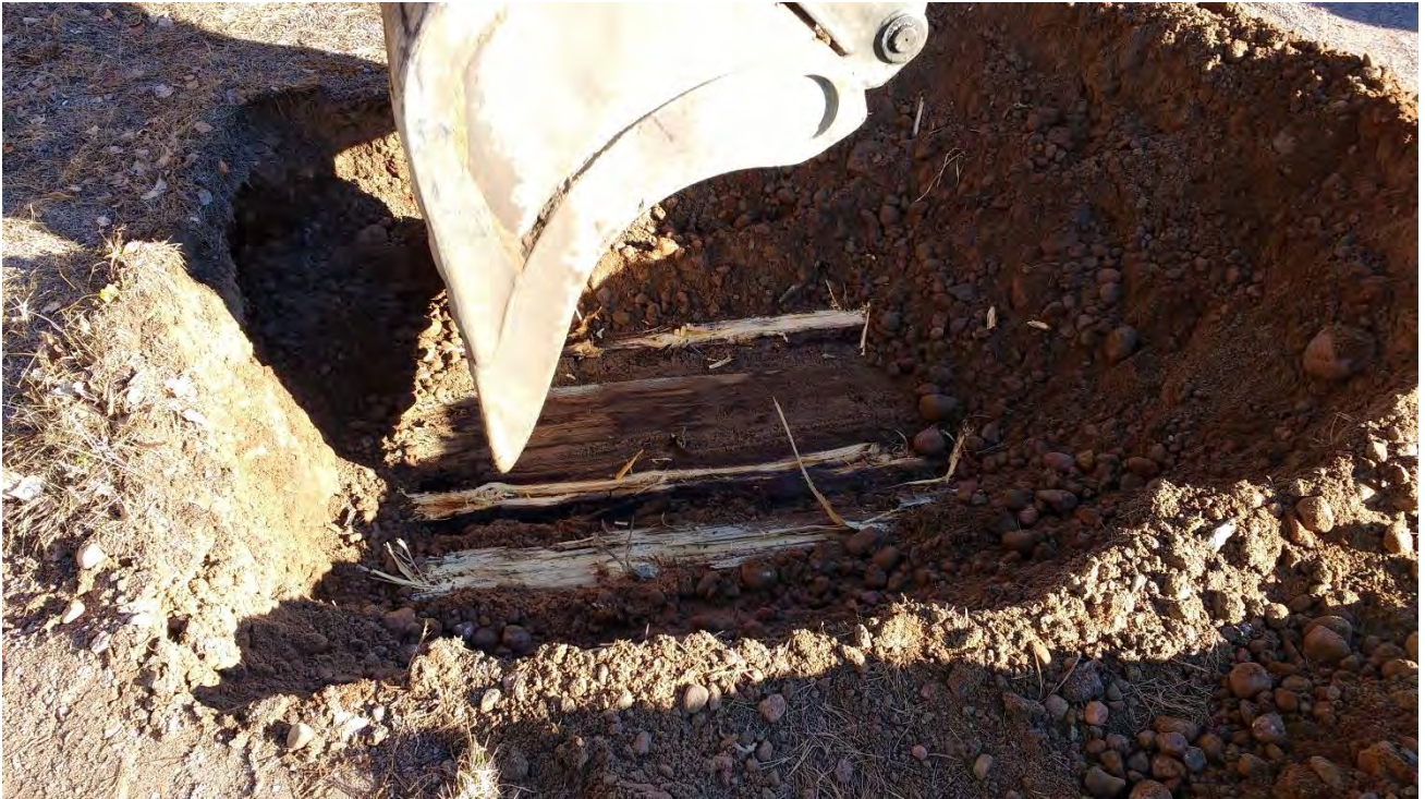
Kuva 5. Koekuopassa KK17 todettiin puuarina.
