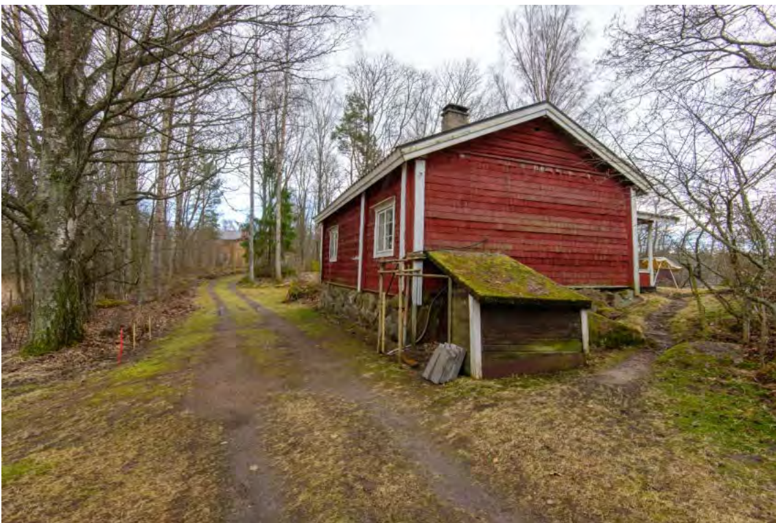
AKDG5422:4 Aluetta Fantsnäsin päärakennuksen pohjoispuolella. Kuva pohjoisesta.
