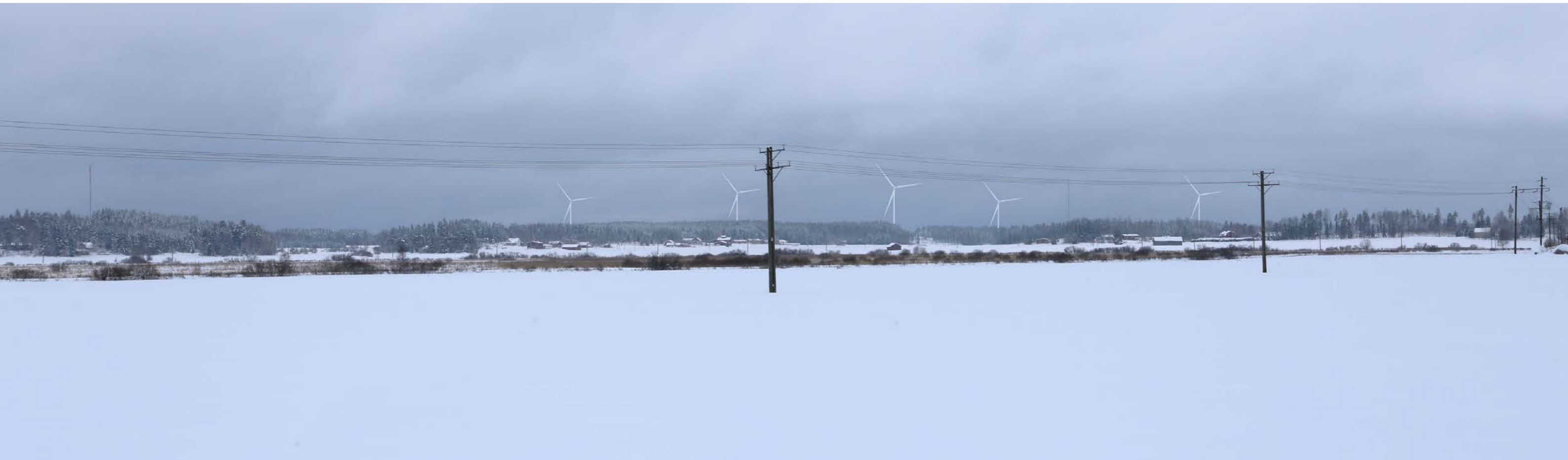
Kuvauspaikka 6. Liljendalin taajaman länsipuolinen peltoalue, Rumpilantie. Etäisyyttä lähimpään tuulivoimalaan 5,4 kilometriä. Kuvattu 50 mm polttovälillä. Voimaloiden kokonaiskorkeus 280 m Fotograferingsplats 6. Åkerområde väster om Liljendals tätort, Drombomvägen. Avståndet till närmaste vindkraftverk är 5,4 kilometer. Fotograferat med 50 mm brännvidd. Kraftverkens totalhöjd 280 m
