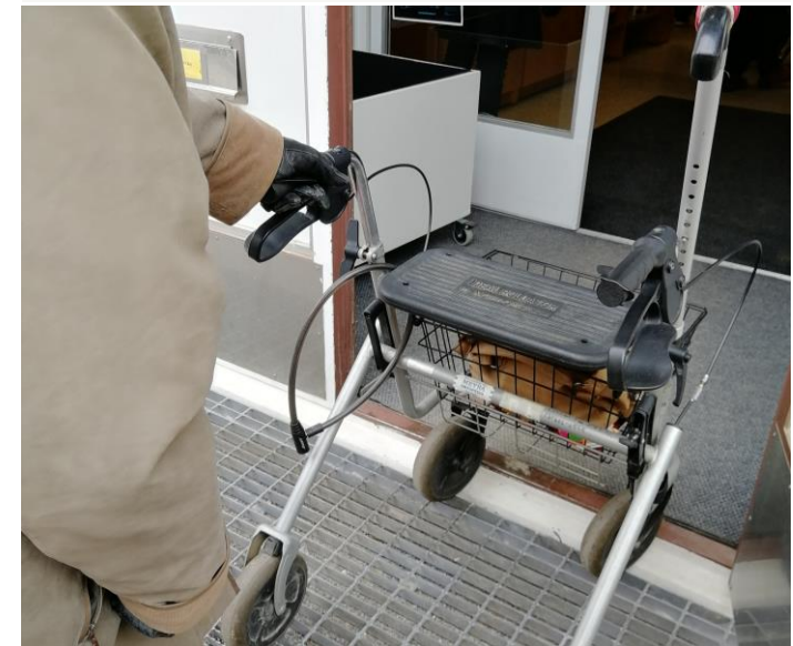
KUVA 24. SISÄÄNKÄYNNIN KYNNYS OLI KORKEA JA OVEA HANKALA AVATA SAMALLA KUN ROLLAATTORIA TYÖNSI SISÄLLE.
