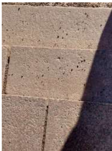
Kuva 16 Loviisan Kruunuapteekin portaat ilman kontrastiraitoja
