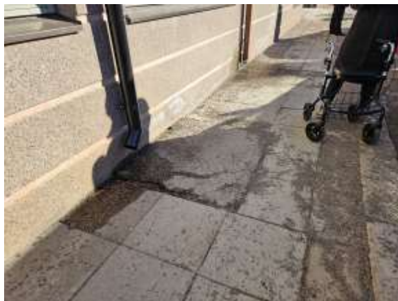
Kuva 3 Esplanadin läheisyydessä jalkakäytävällä asfaltoitu paikkaus
