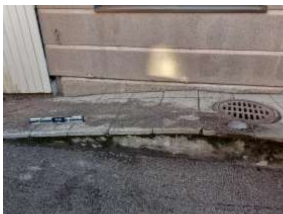
Kuva 35 Rampin kaltevuutta mitataan
