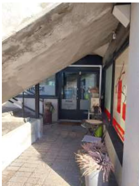
Kuva 25 Hyggen esteetön sisäänkäynti rappusten alta
