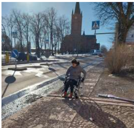
Kuva 30 Haastavaa kulkea pyörätuolilla jalkakäytävän rännikourun yli
