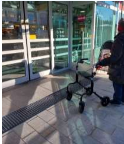
Kuva 5 Kauppakeskus Gallerian sisäänkäynnin edustan laatoitus ja ritilä
