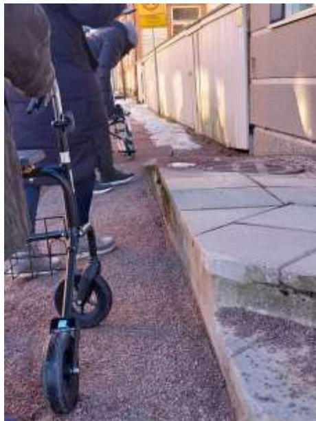
Kuva 34 Liian jyrkkä ja kapea ramppi ilman kaiteita
