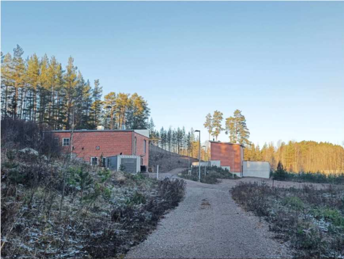
Vedenottamon kaksi rakennusta etelästä päin kuvattuna. Taaempi on vuonna 2015 rakennettu pumppaamo ja vesisäiliö.
