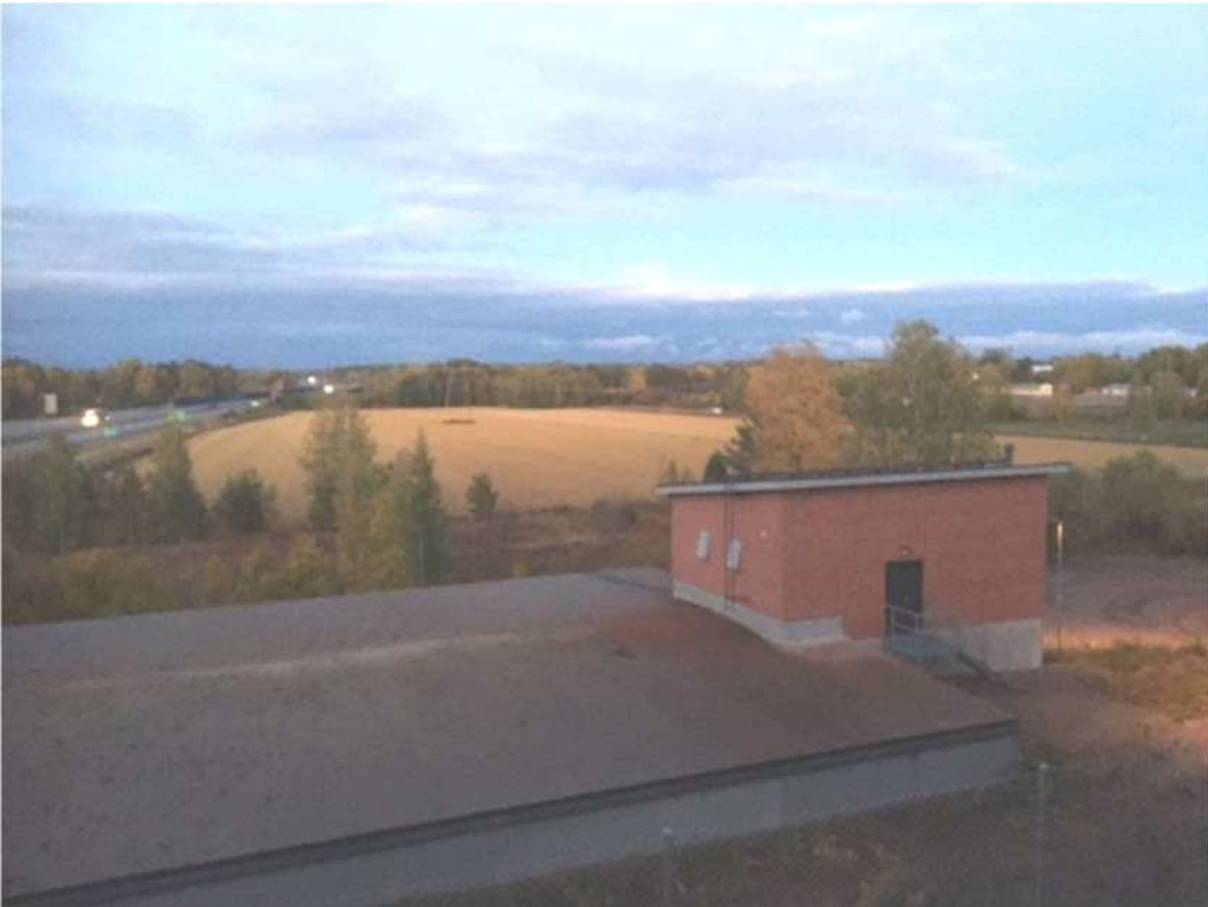
Kuva 12. Näkymä harjulta kaakkoon vuonna 2015 rakennetun pumppaamon ja vesisäiliön yli joen suuntaan.
