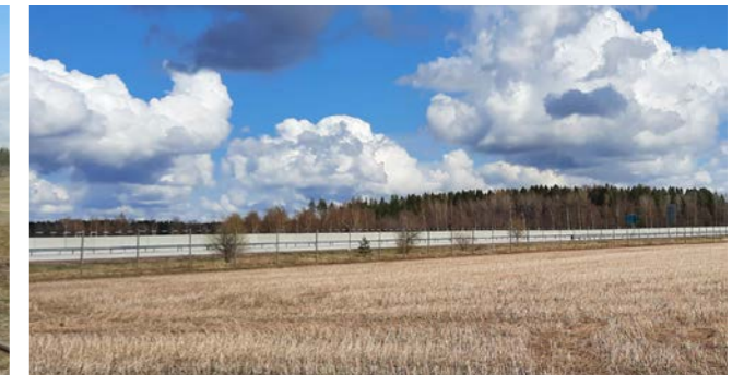
Moottoritien betoninen melueste.
