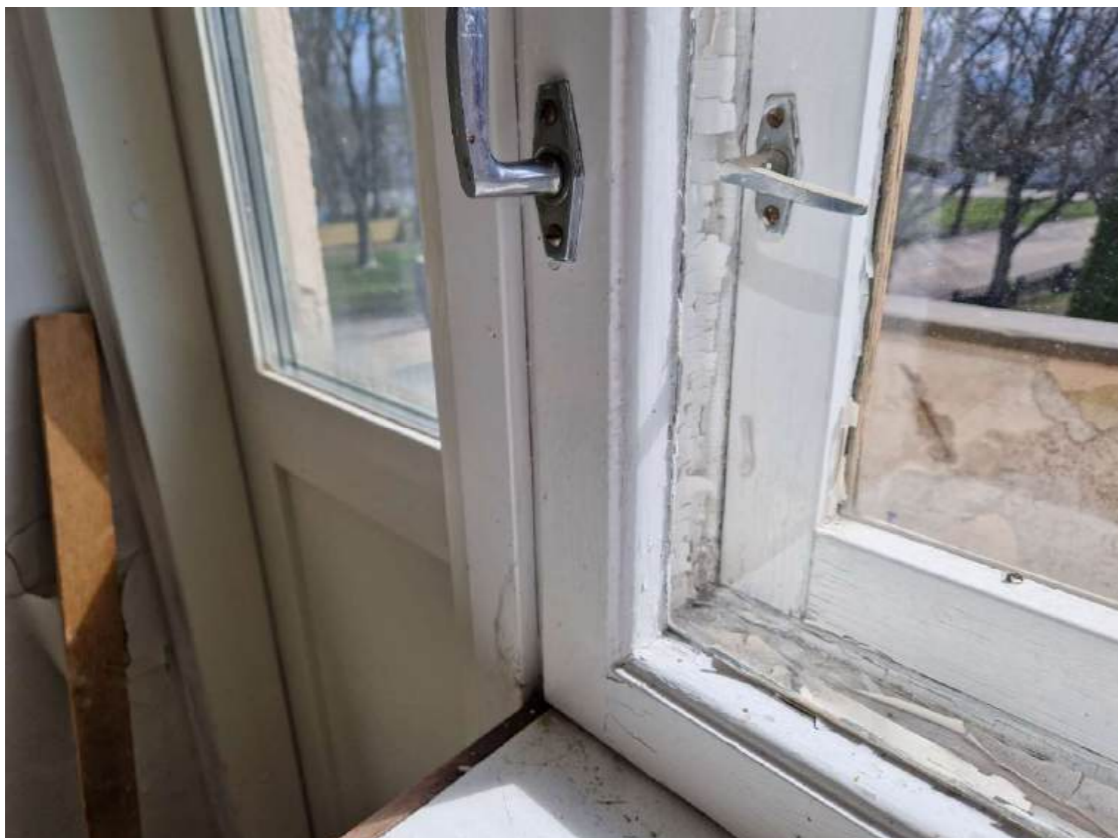
Kuva 46. Toisen parvekkeellisen hotellihuoneen ikkuna ja ovi. Parveke on teräsbetoninen. Ovi on vaihdettu, ikkunat ovat sen sijaan ilmeisesti alkuperäiset.
