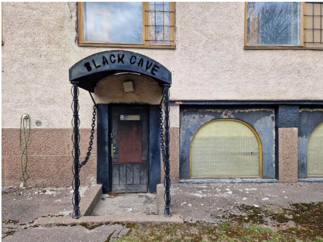
Kuva 30. Sisäänkäynti kellarin. Paikalla on ollut alun alkaen pihassa syvennys ja ovi. Kaari-ikkunat on tehty ilmeisesti uima-allasosastomuutoksen myötä vuonna 1975.
