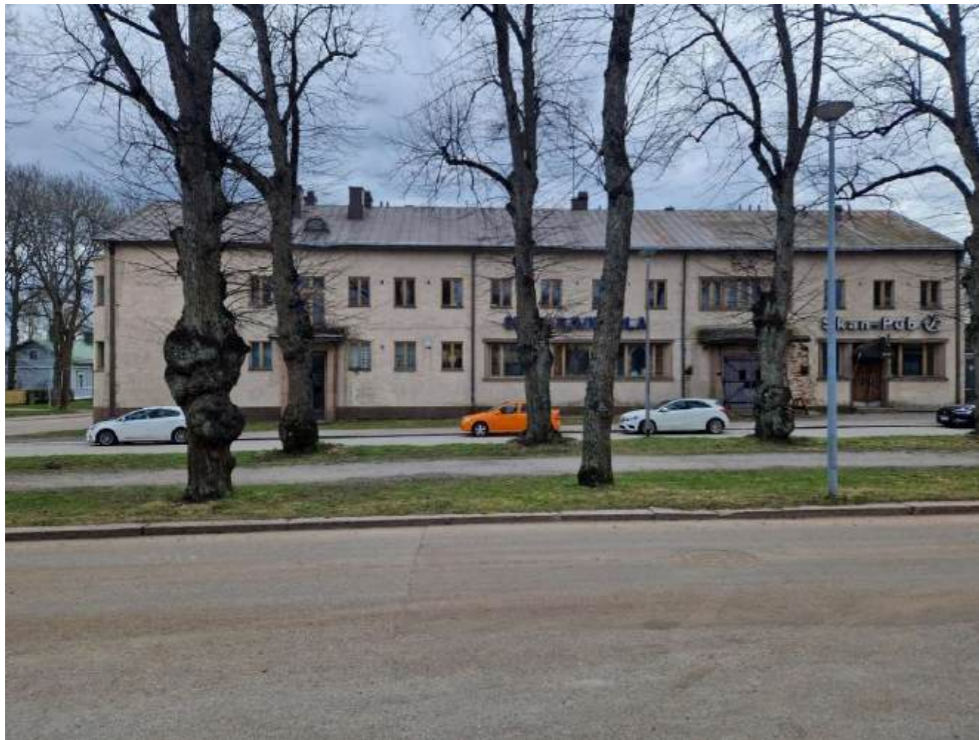
Kuva 21. Julkisivu pohjoiseen Karslkronabulevardille.
