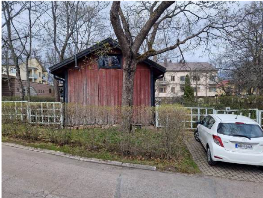
Kuva 51. Piharakennuksen julkisivu etelään.
