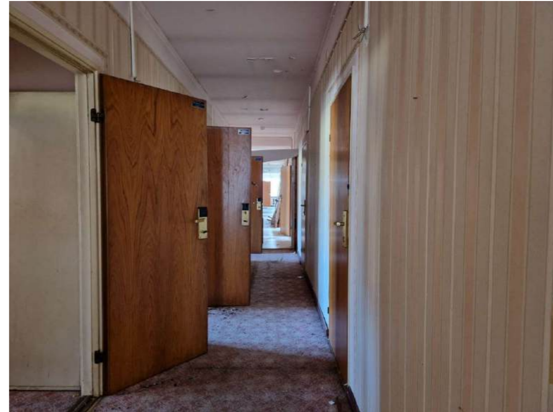
Kuva 43. Hotellin käytävää itään päin kuvattuna.
