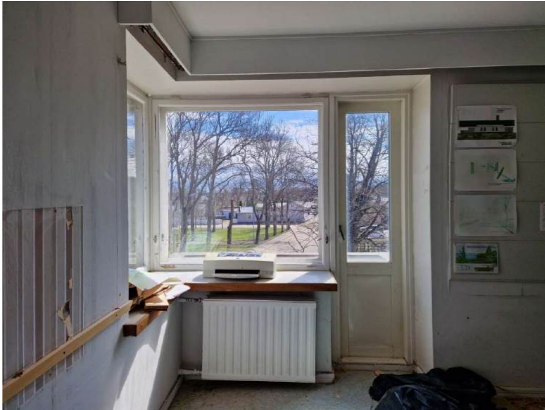
Kuva 45. toisen kerroksen kulmahuone. Kahdessa hotellihuoneessa on ollut parveke.
