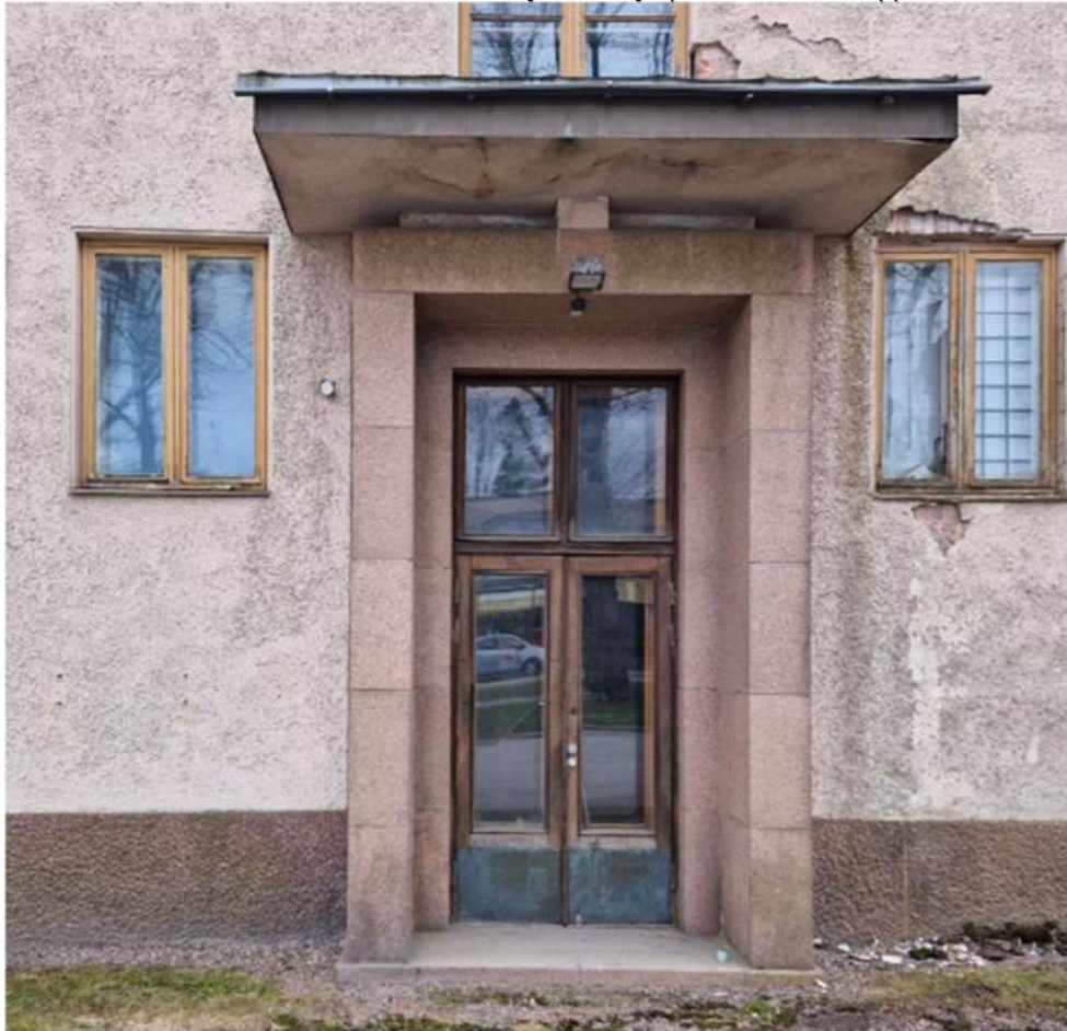
Kuva 26. Pohjoisjulkisivu itäisin ovi on alkuperäinen. Se on valmistettu tammesta samoin kuin sen yläpuolella olevat ikkunat.
