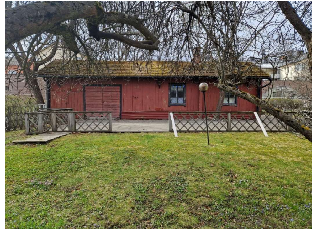
Kuva 54. Piharakennuksen julkisivu itään.
