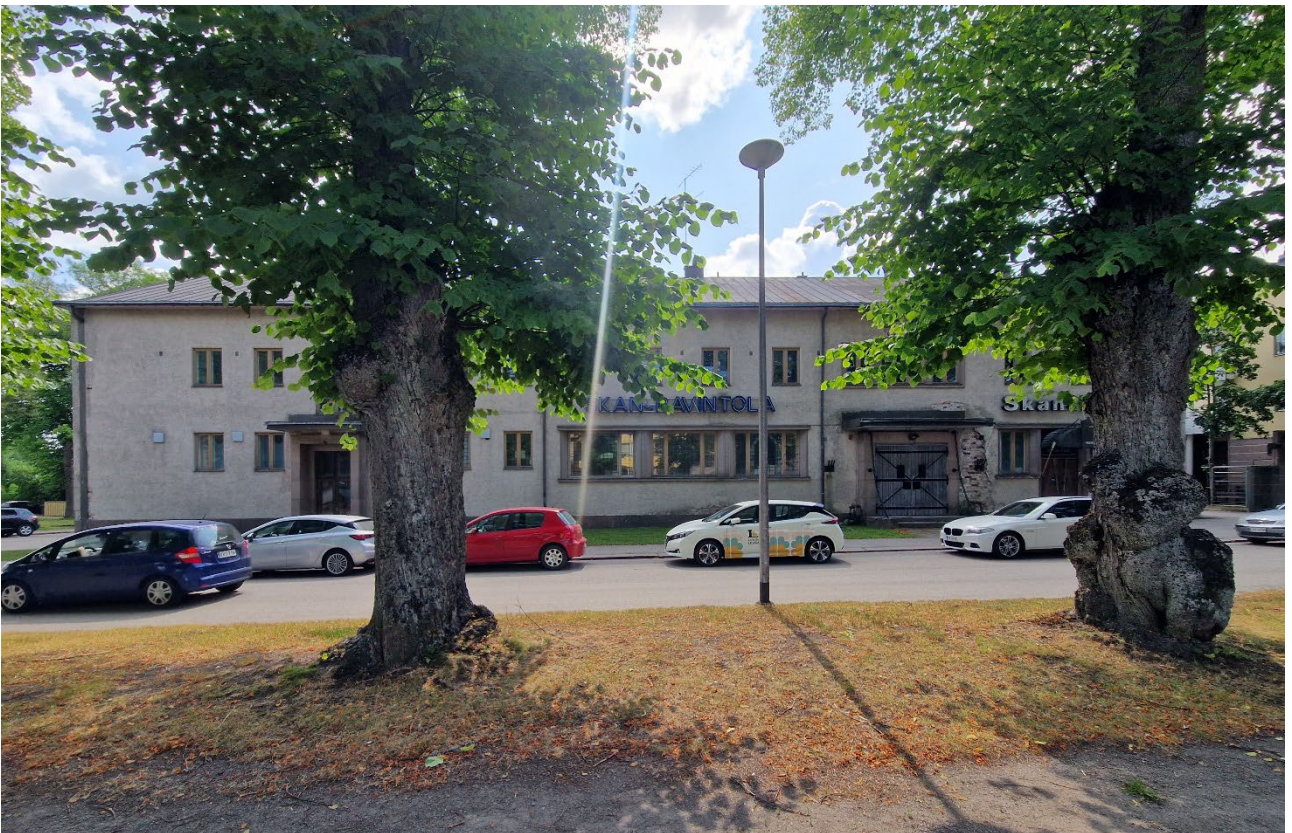
Tiilirakennus Karlskronabulevardilta katsottuna. Rakennus on alun perin ollut hotelli ja siellä on myöhemmin ollut ravintola- ja yökerhotoimintaa.
