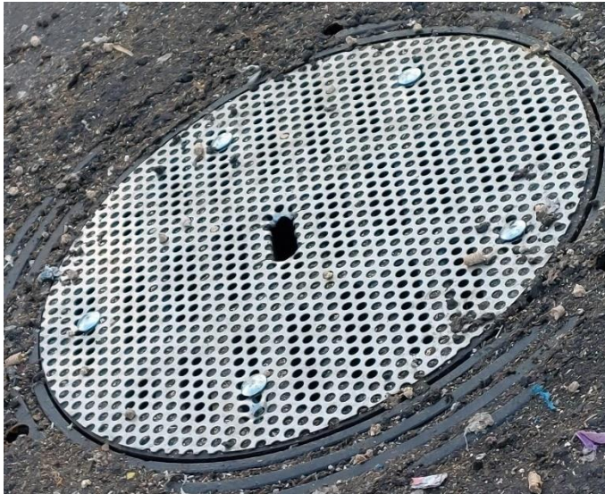
Kuva 5. Hulevesikaivon ritiläkanteen asennettu verkko.
