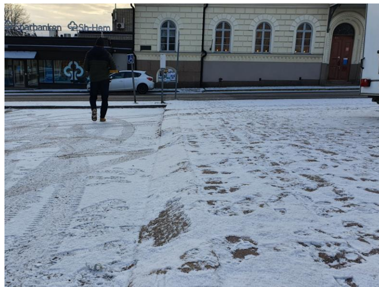
KUVA 8. Nupukivipintainen tori ja hankalat reunakivet INVA-paikalta.
