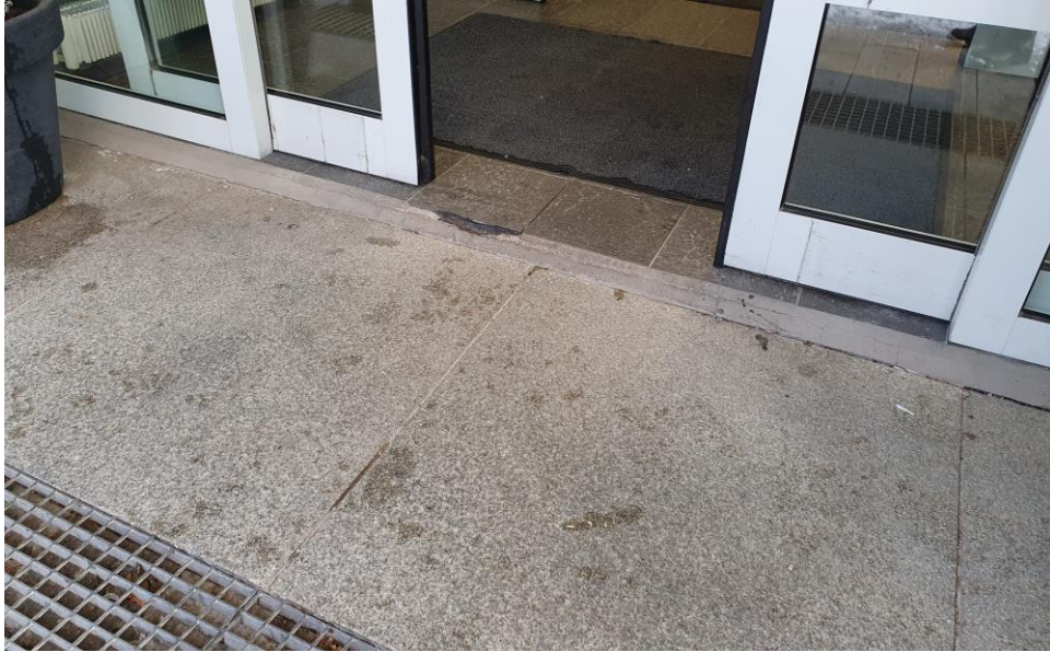
KUVA 6. Ritilän iso silmäkoko ja kynnyks automaattiovien edessä.
