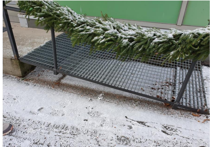
KUVA. 13. Ramppi on keskeltä notkahtanut, eli se tulisi tukea keskeltä.
