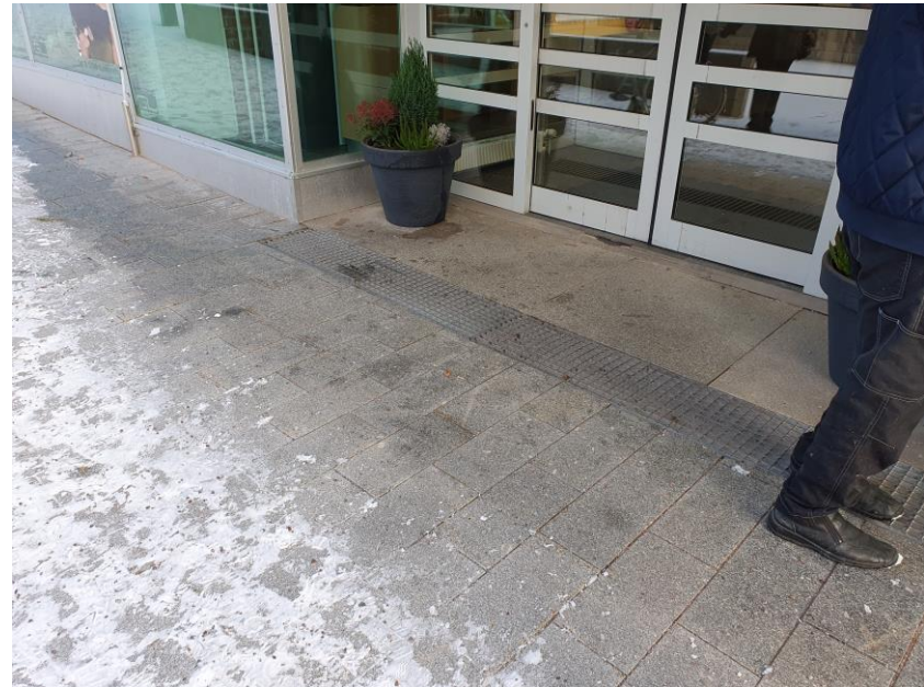
KUVA 5. Sisäänkäynti on nykyään melko esteetön.
