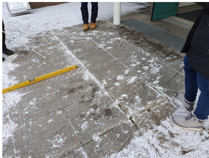
KUVA 2. Sisäänkäynnin kynnys/painuma.
