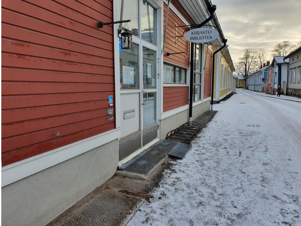
KUVA 14. Kirjaston sisäänkäynnille tulisi toteuttaa leveämpi tasanne ja luiska pohjoisen suunnasta.
