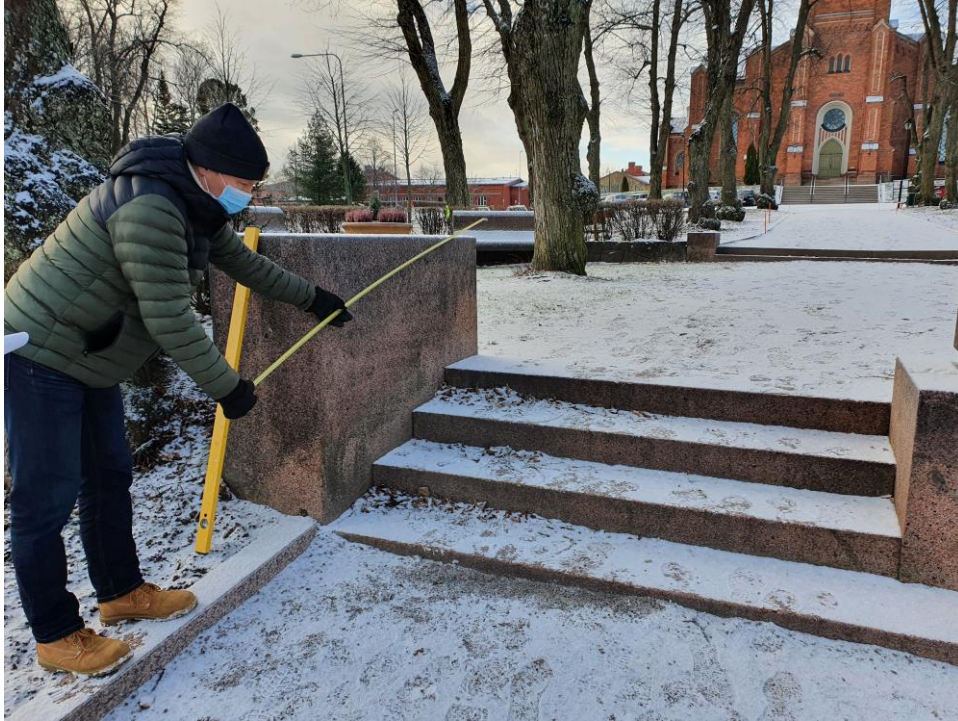
KUVA 9. Käsijohteiden paikat ja kompastumisvaaran aiheuttava alin porras, jonka korkeus poikkeaa muista.
