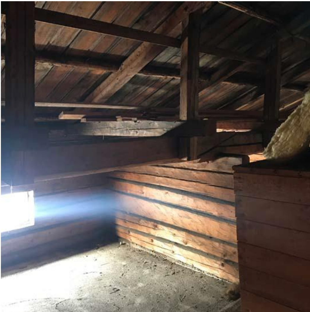
Fotografi tomt 36 huvudbyggnad, vindsvåning. Bjälklag i betong som lades till i samband med förändringsarbeten klart synlig.
