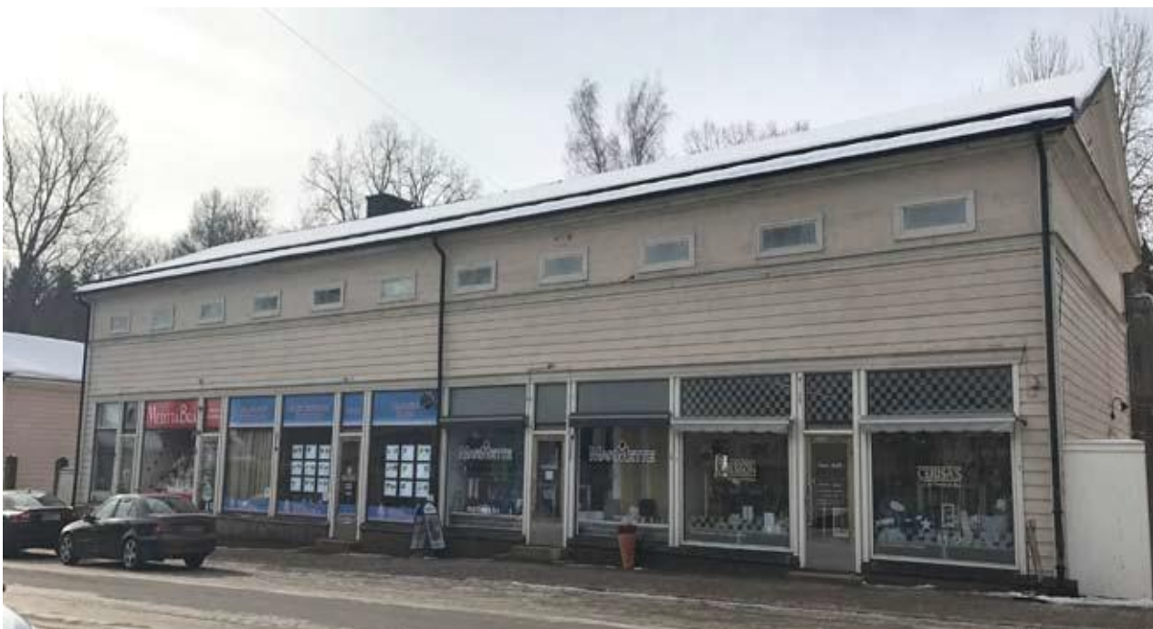
Tomt 36, huvudbyggnad, fasad mot Alexandersgatan med nuvarande utseende.
