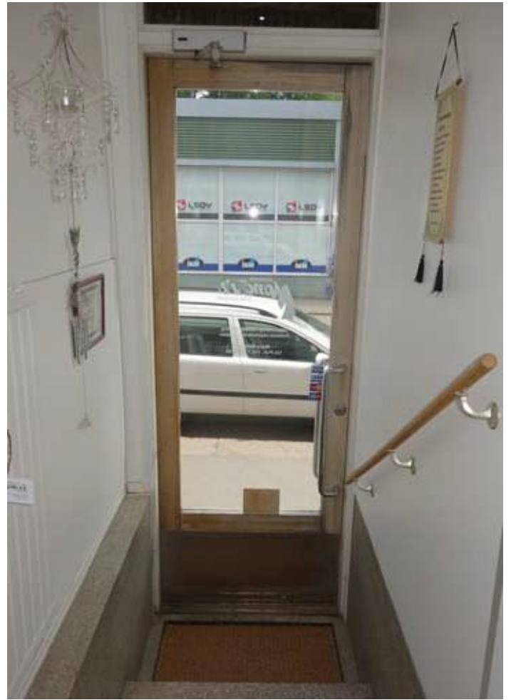
Tomt 36 Byggnad R1 vy över butikslokal.
