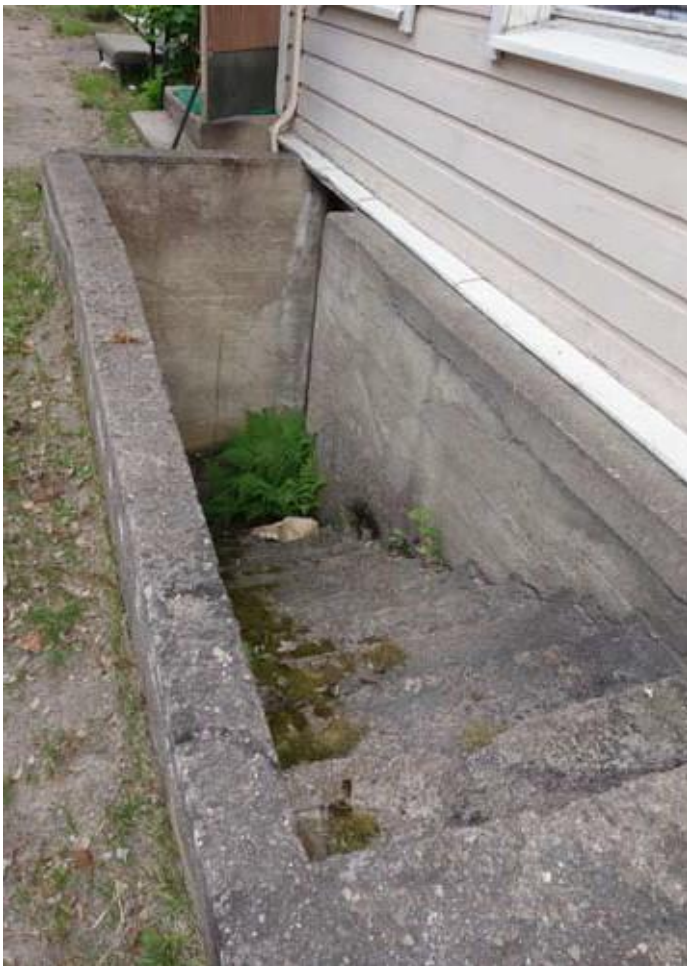
Tomt 36 Byggnad R1 trappa till källaren.
