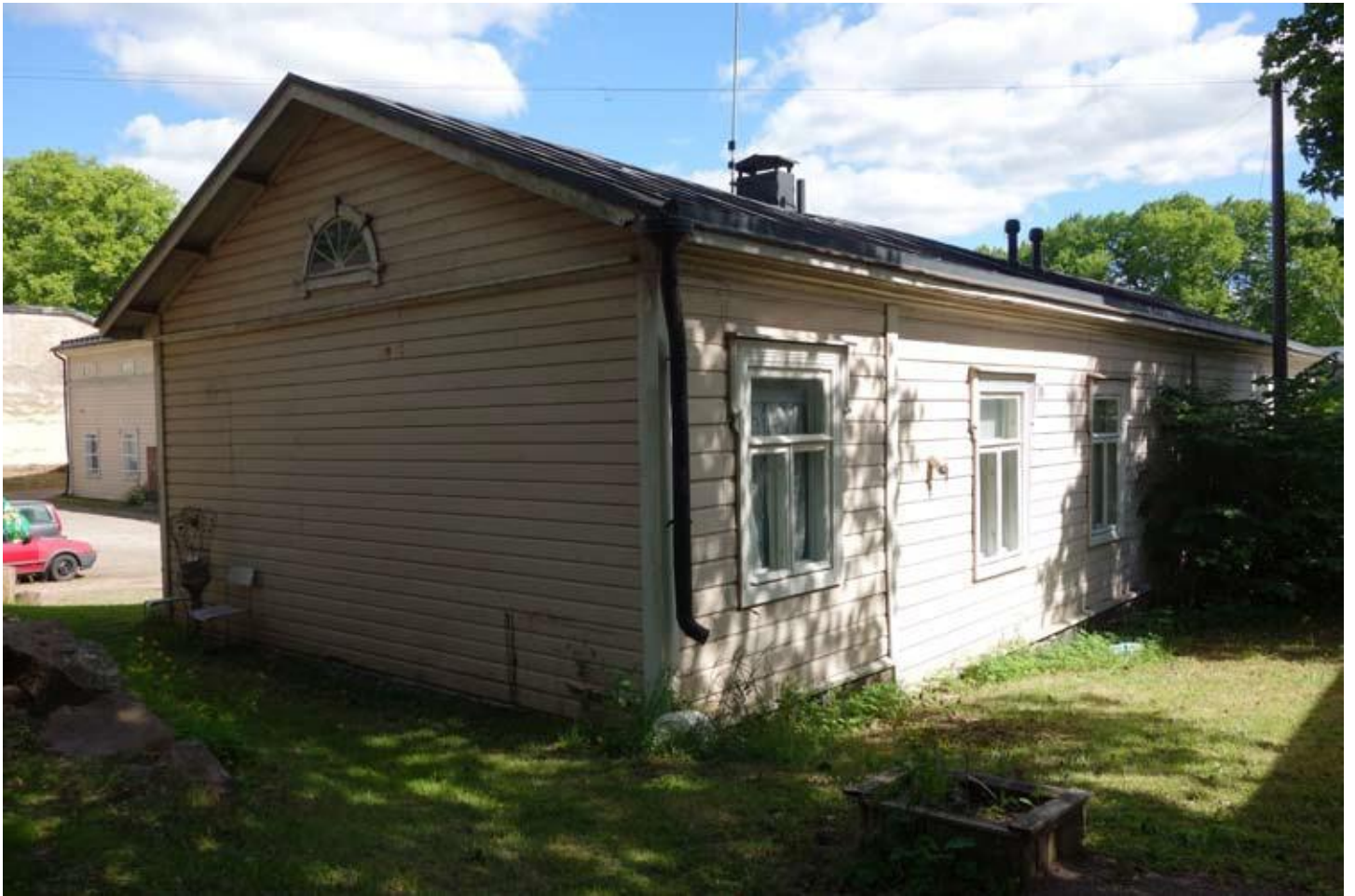
Tomt 36 Byggnad R2 sedd från brandgränden mellan tomterna 36 och 37. Förlängningen av byggnad R2 skiljer sig märkbart.
