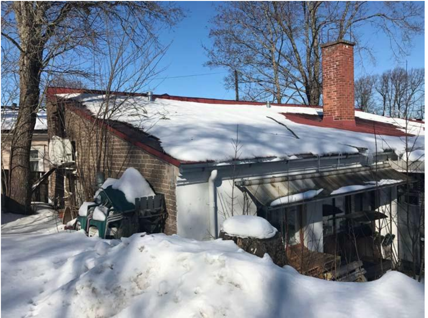
Byggnad R6 som den ser ut idag sedd från innergården/västra gaveln.
