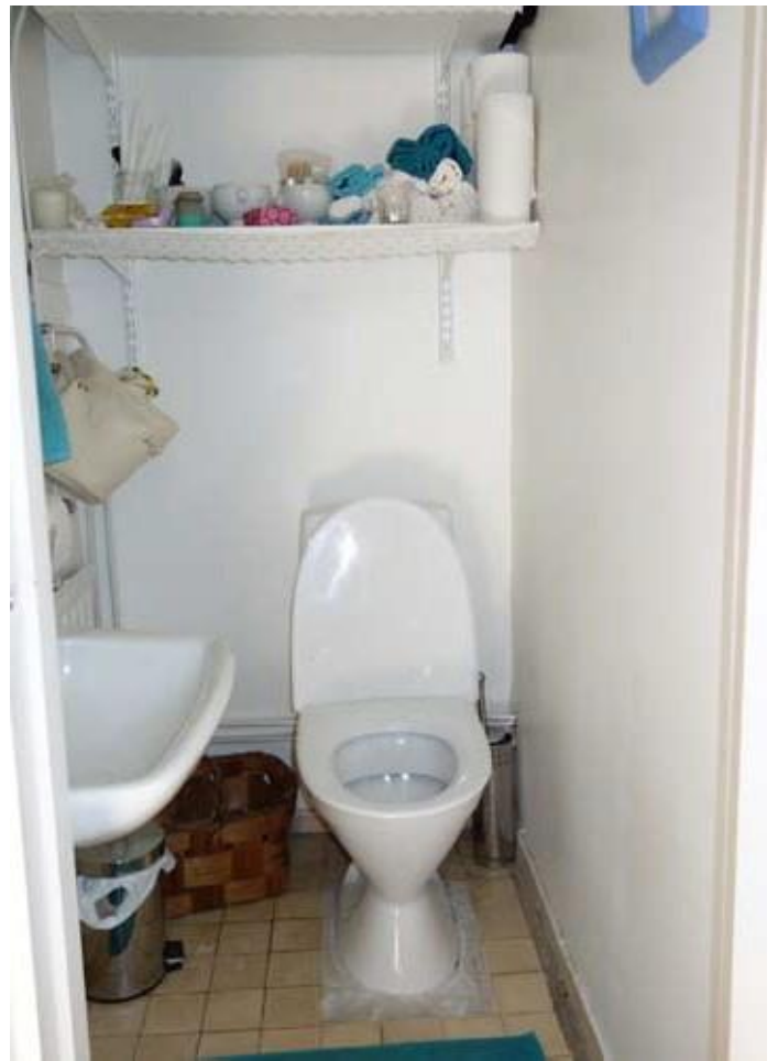
Tomt 36 Byggnad R1 befintliga våtrum.
