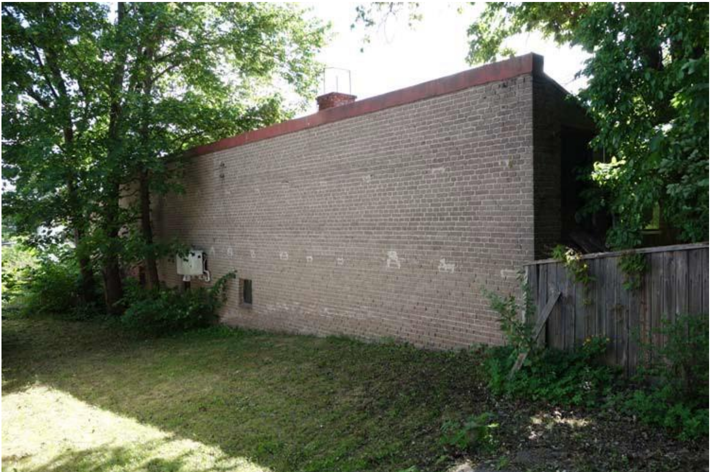
Tomt 37 Byggnad R6 brandmur.
