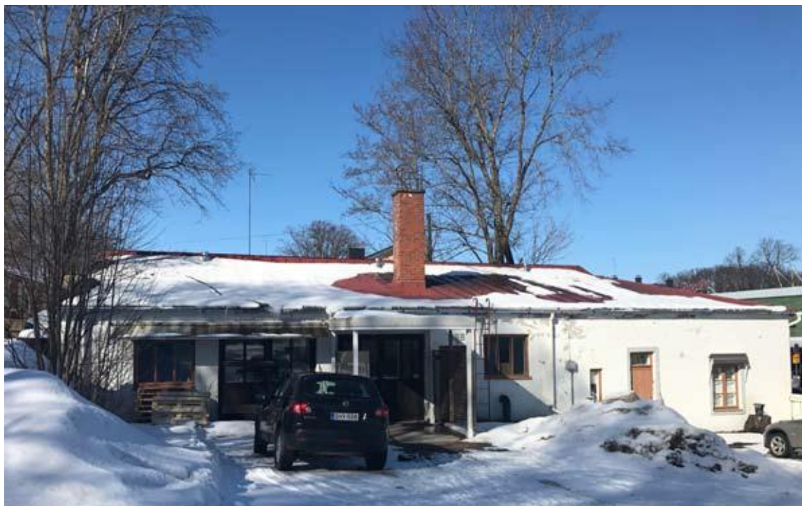
Byggnad R6 som den ser ut idag sedd från innergården.
