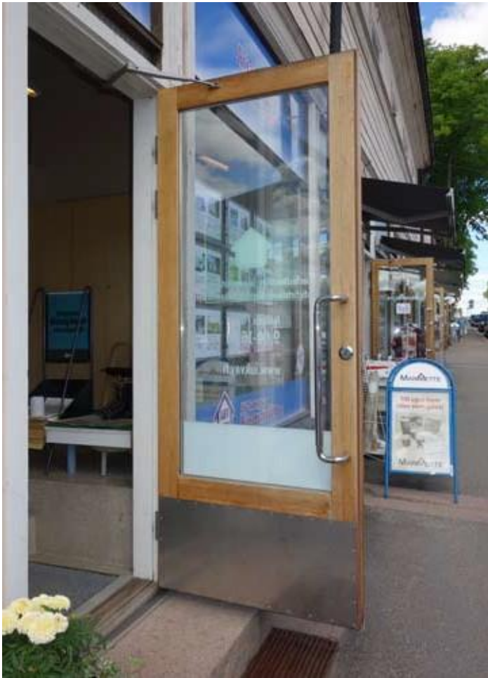
Tomt 36 Byggnad R1 nya dörrar till butikslokalerna
