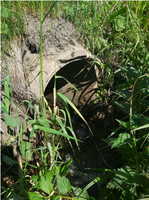
KUVA 9 Ennen Marsbäcken puroon yhtymistä vedet kulkevat kuvassa 1 esitetyn betonirummun nro 4 läpi
