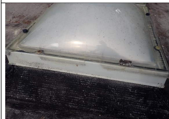
Kuva 27. Ikääntynyt kattoikkuna
