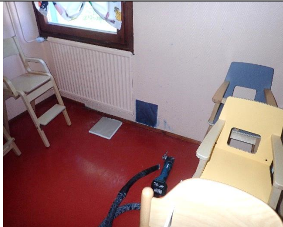
Kuva 15. Rakenneavaus ulkoseinään
