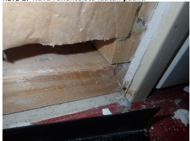
Kuva 2. Kuva rakenteista laatan päällä
