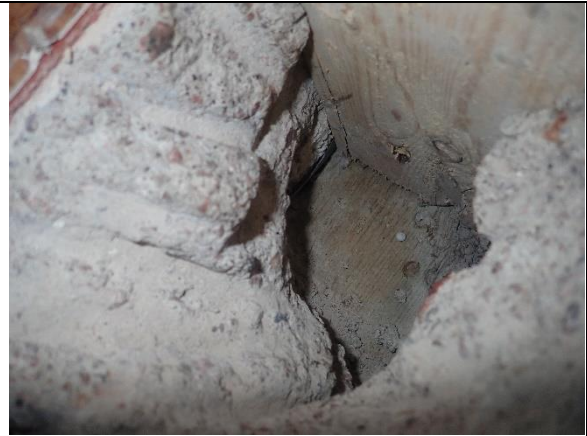
Kuva 9. Pystytolppa lähtee betonilaatan allaolevan alajuoksun päältä
