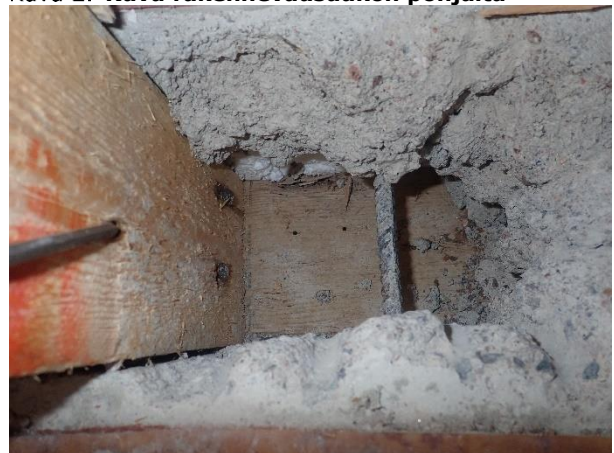
Kuva 2. Kuva rakenneavausaukon pohjalta
