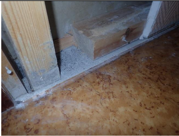
Kuva 8. Rakenneavaus ryhmähuoneessa, pystytolppa jatkuu betonin alle.
