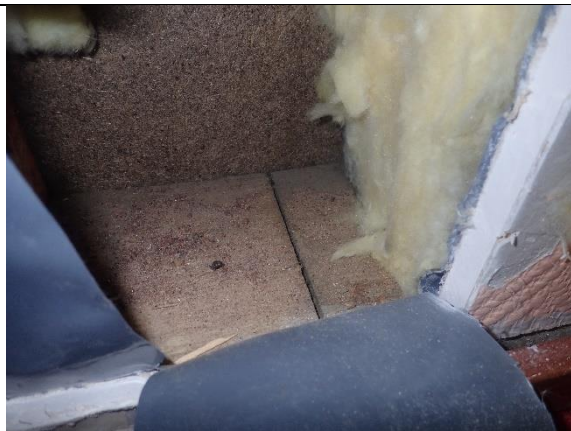
Kuva 17. Ulkoseinärakenne avattu, lämmöneriste poistettuna
