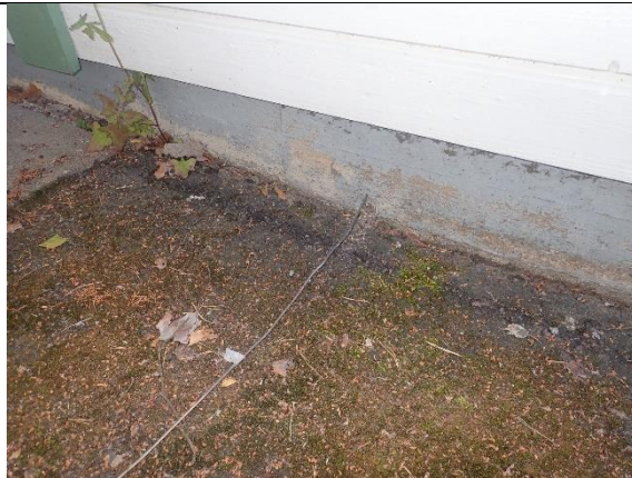
Kuva 41. Sokkelin "reikä" maanpinnan tasossa
