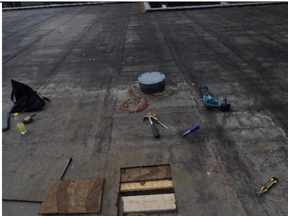
Kuva 33. Rakenneavaus 2 vesikatolla, tilan 16 kohdalla
