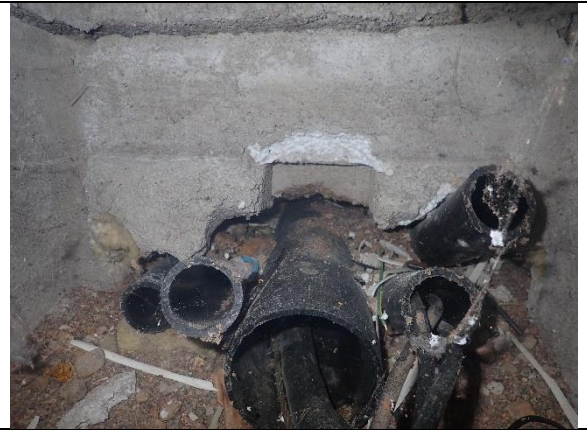
Kuva 4. Epätiiviiit läpiviennit
