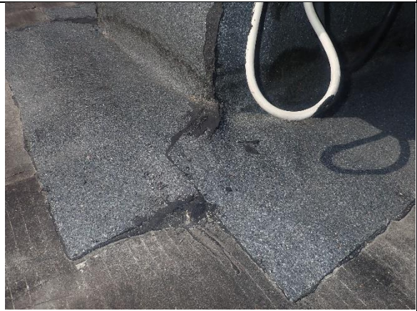
Kuva 38. Kermin liitos ylösnostoon
