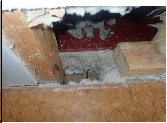
Kuva 12. Rakenne avattuna leikkihuoneesta katsottuna
