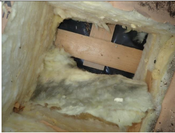
Kuva 37. Vesikaton rakenne avattuna
