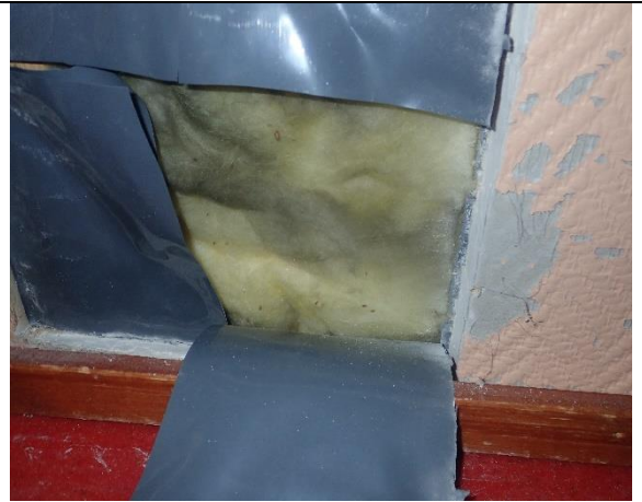
Kuva 16. Ulkoseinärakenne avattuna
