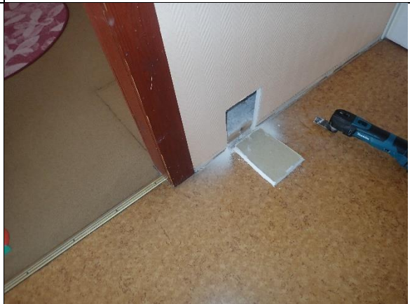
Kuva 7. Rakenneavaus ryhmähuoneessa
