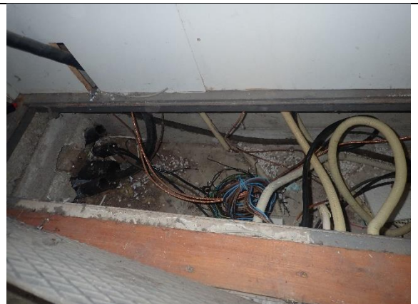
Kuva 2. Sähkökaapin alapuolinen tila
