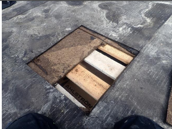
Kuva 29. Rakenneavaus 1 vesikatolla, tilan 06 kohdalla
