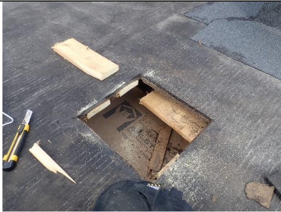
Kuva 35. Rakenneavaus 3 vesikatolla, sosiaalitalon kohdalla
