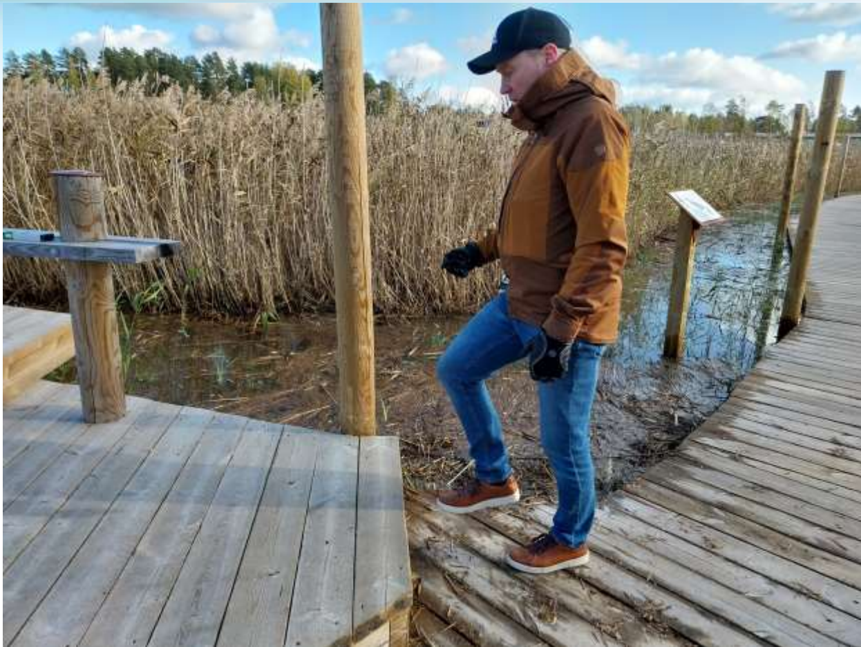
Bild 17 Ändan av vassruggsstigens tillgängliga pausstig, där det finns ett högt steg utan ledstång
