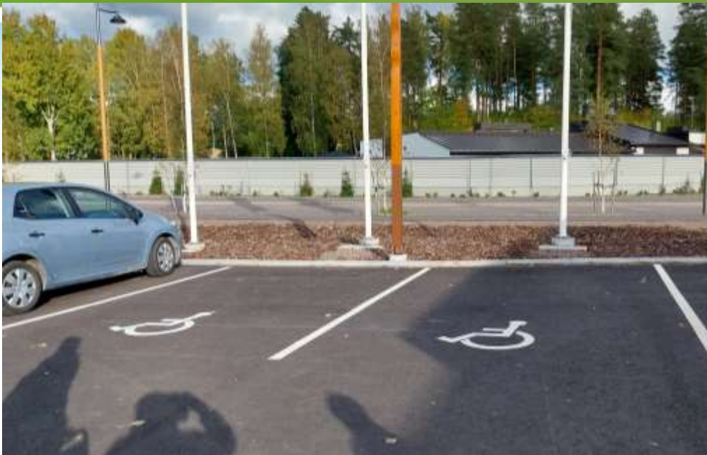
Bild 23 K-market Drottningstrandens invaparkeringsplatser utan ISA trafikmärke
