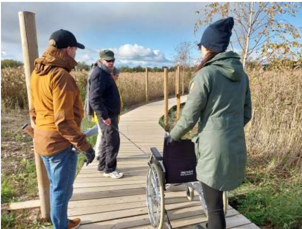
Bild 14 Vassruggsstigen utan skyddskant
