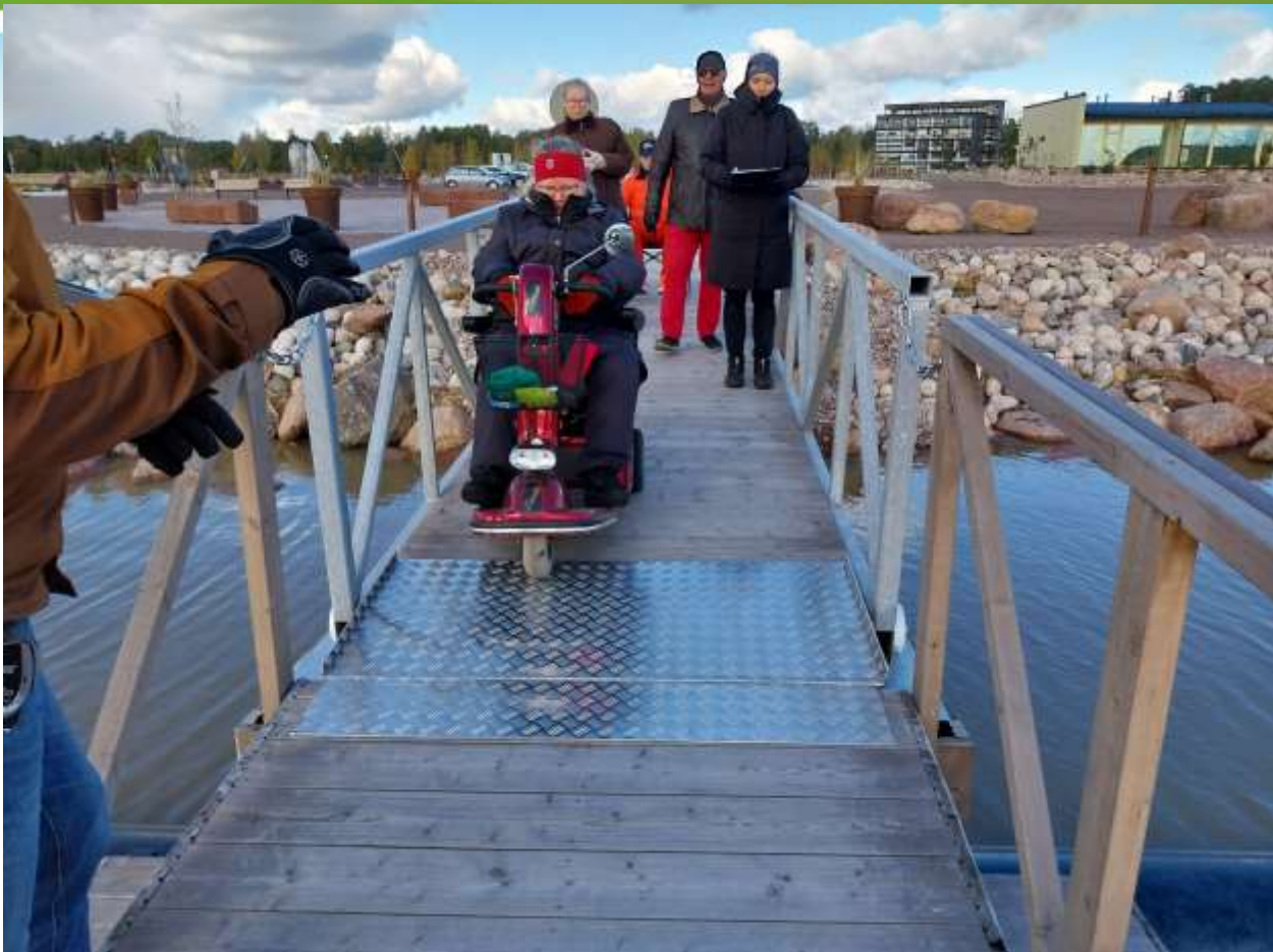
Bild 11 Fogställe för den flytande gatans förbindelsebrygga
