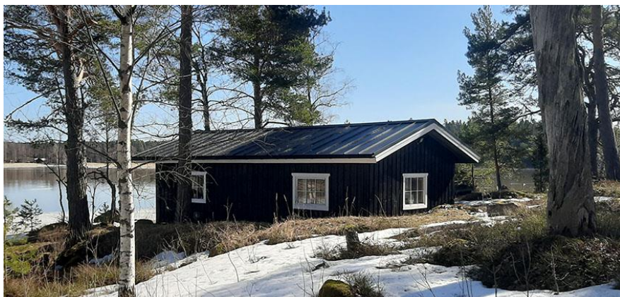
Bild 13. Båthuset på den nordöstra udden på byggplats 2.
