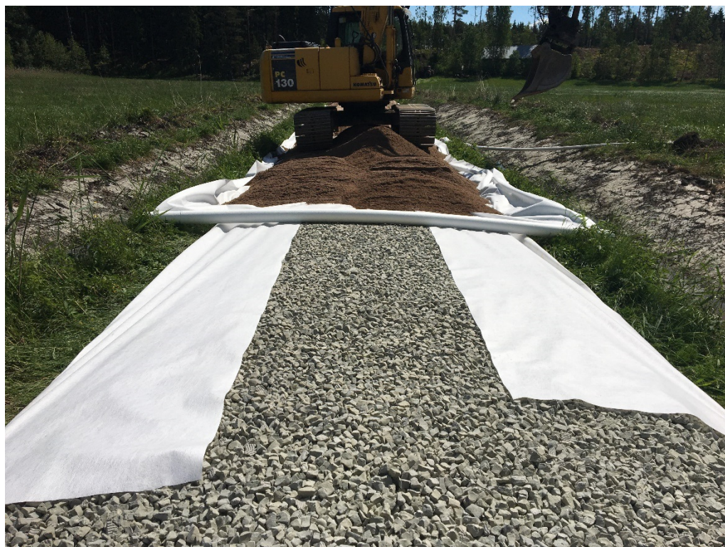
Bild 2. Furunäs-Edö väglag sommaren 2022; Förbättring av vägens struktur och dränering, höjning av väg som utsätts för översvämning vid högt havsvattenstånd. Ett ca 50 cm tjockt lager skumglas bredds ut och "paketeras in" i fiberduk, sedan körs det på ca 20-30 cm grus. (bild Kindstedt S.)
