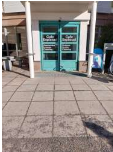
Bild 2 Området med de belagda plattorna och gallret framför ingången till Esplanad
