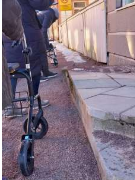
Bild 34 För brant ramp som saknar en ledstång
