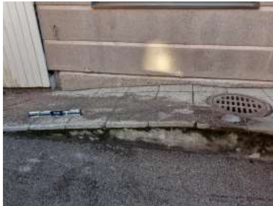
Bild 35 Rampens lutning mäts
