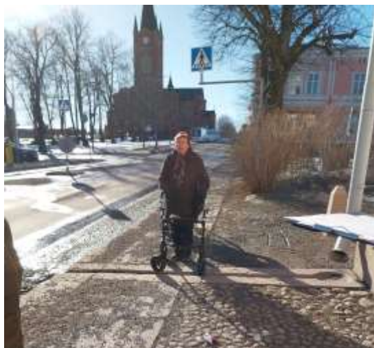
Bild 29 Utmanande att ta sig fram med rollator över vattenrännan på trottoaren
