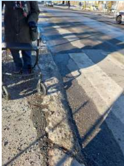
Bild 14 Packad snö på skyddsvägens ramp
