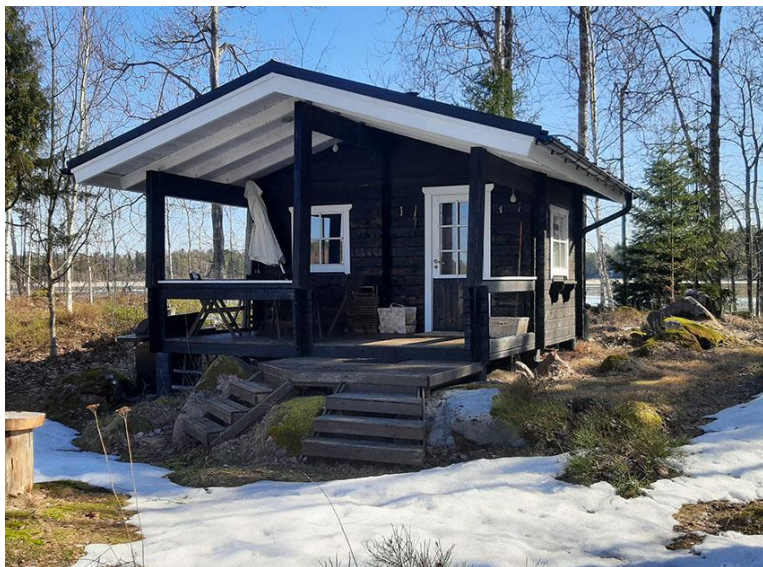
Bild 10. Bastun på byggplats 2.
