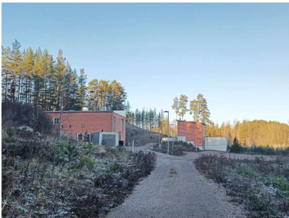
De två vattentäcksbyggnaderna fotograferade från söder. Byggnaden längre bak är pumpstationen och vattenbehållaren byggd 2015.
