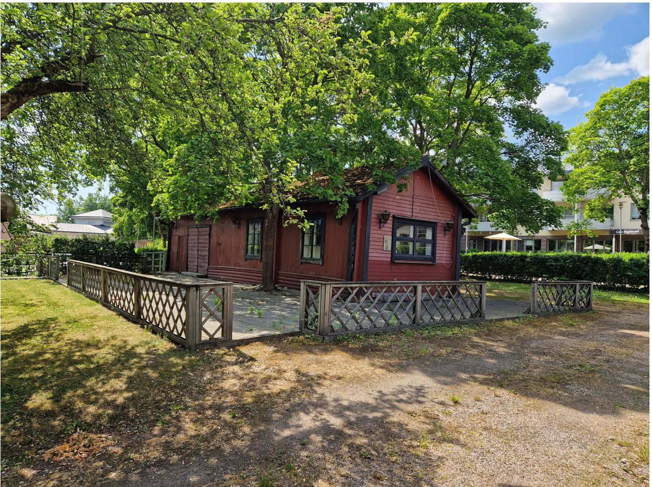
Den andra byggnaden på planeringsområdet är en äldre träbyggnad, som främst använts som kafé och restaurang sommartid.
