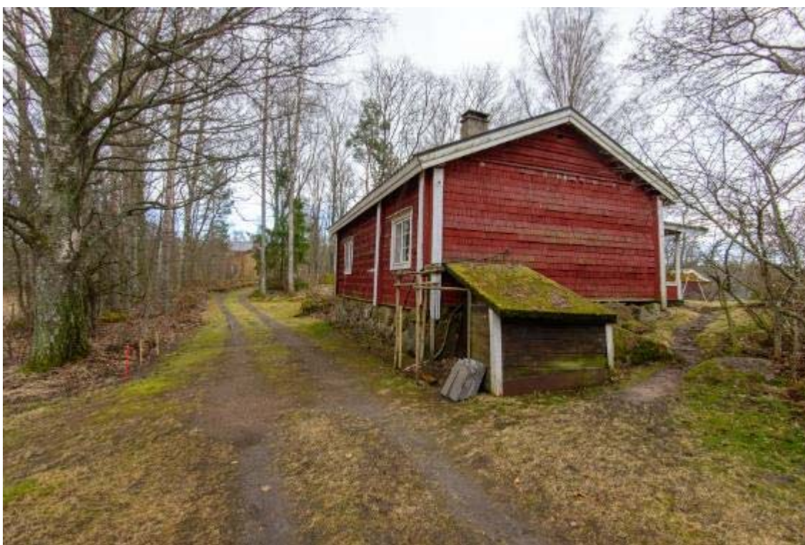
AKDG5422:4 Område norr om huvudbyggnaden på Fantsnäs. Bilden tagen från norr.
