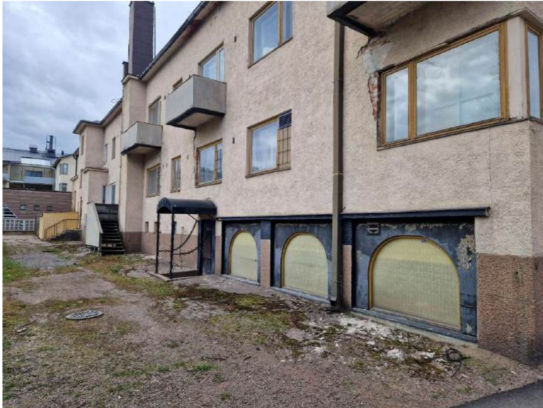
Kuva 29. Eteläjulkisivua länttä kohti. Kolmessa hotellihuoneessa on parveke, sen jälkeen julkisivusta erkanee kellarista nouseva piippu, sen toisella puolella vuonna 1991 tehty uusi oviyhteys pihalle. Sen takana porrashuone-erkkeri.
