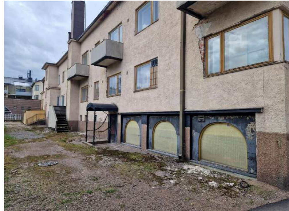
Kuva 27. Eteläjulkisivua. Toisen kerroksen parvekkeet ovat teräsbetonirakenteisia. Etualalla on kellarin uima-allasosastomuutoksen yhteydessä tehdyt kaari-ikkunat. Taaempana on uusi ulko-ovi portaineen vuodelta 1991.
