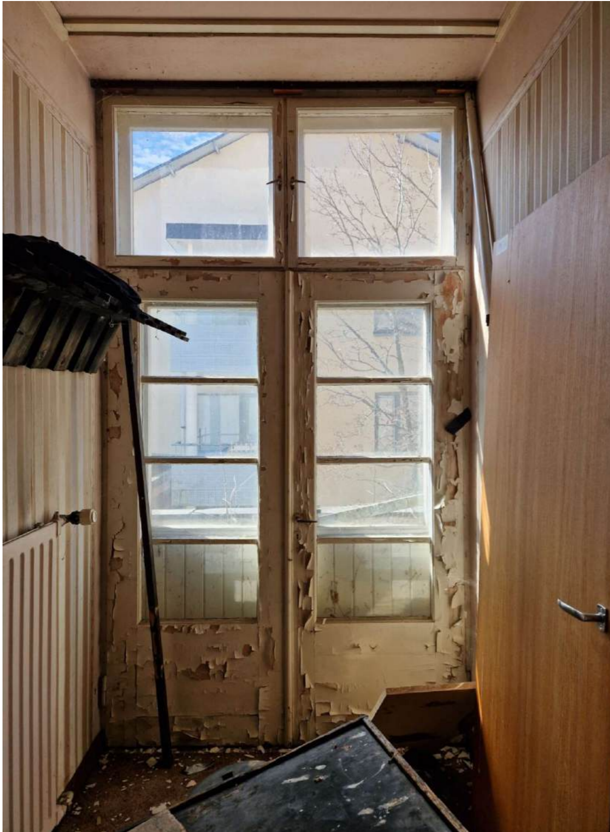
Kuva 49. Hotellikäytävän länsipään ovi.
