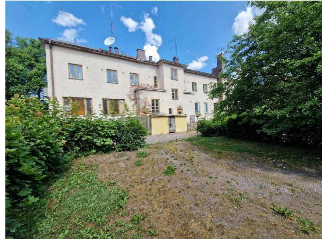
Kuva 31. Eteläjulkisivun erkkeri portaan kohdalla. Ensimmäisessä kerroksessa erkkerin muodostaa portaan lisäksi huoneet sen molemmin puolin. Erkkerin ikkunat ovat muista poiketen ruutuikkunat. Sen oikealla puolella uusittuja ikkunoita.
