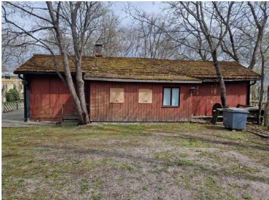
Kuva 52. Piharakennuksen julkisivu länteen.
