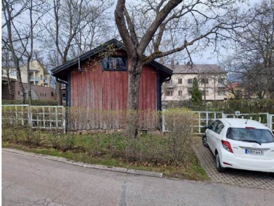
Kuva 51. Piharakennuksen julkisivu etelään.
