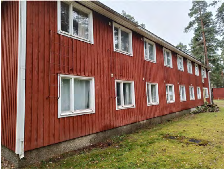
Kuva 46. Tyttöjen majoitustalon länsijulkisivu
