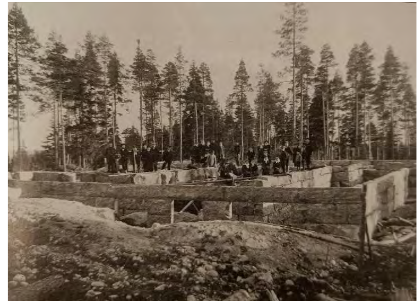
Kuva 6. Kuggomin päärakennuksen perustusten rakentamista. Perustukset on tehty kookkaista graniittikivistä.
