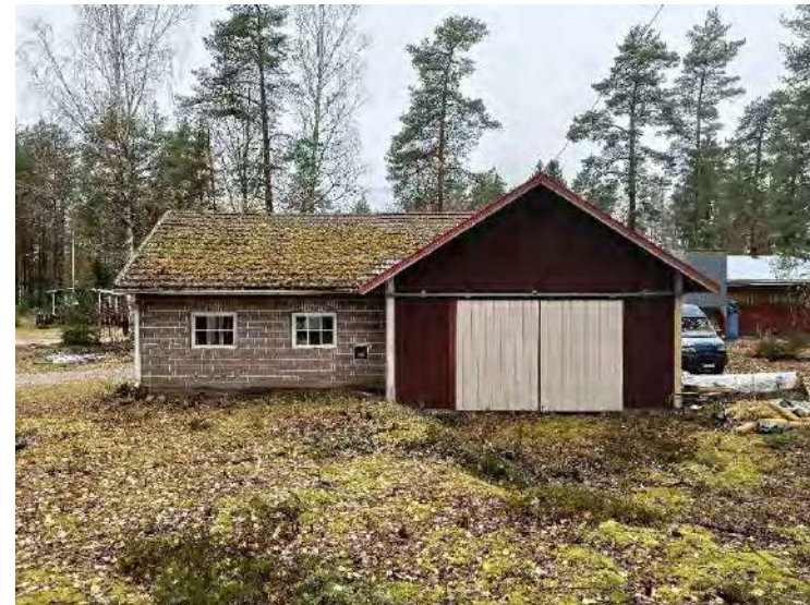
Kuva 37. Tinaverstaan itäjulkisivu, oikealla puuvaraston pääty.
