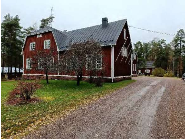
Kuva 9. Päärakennus etelästä saavuttaessa.
