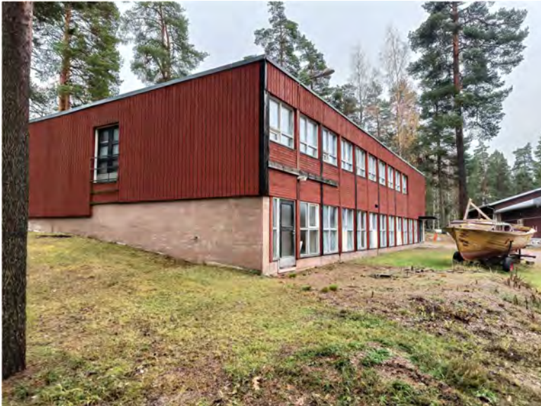
Kuva 52. Poikien asuntola pohjoisesta kuvattuna.
