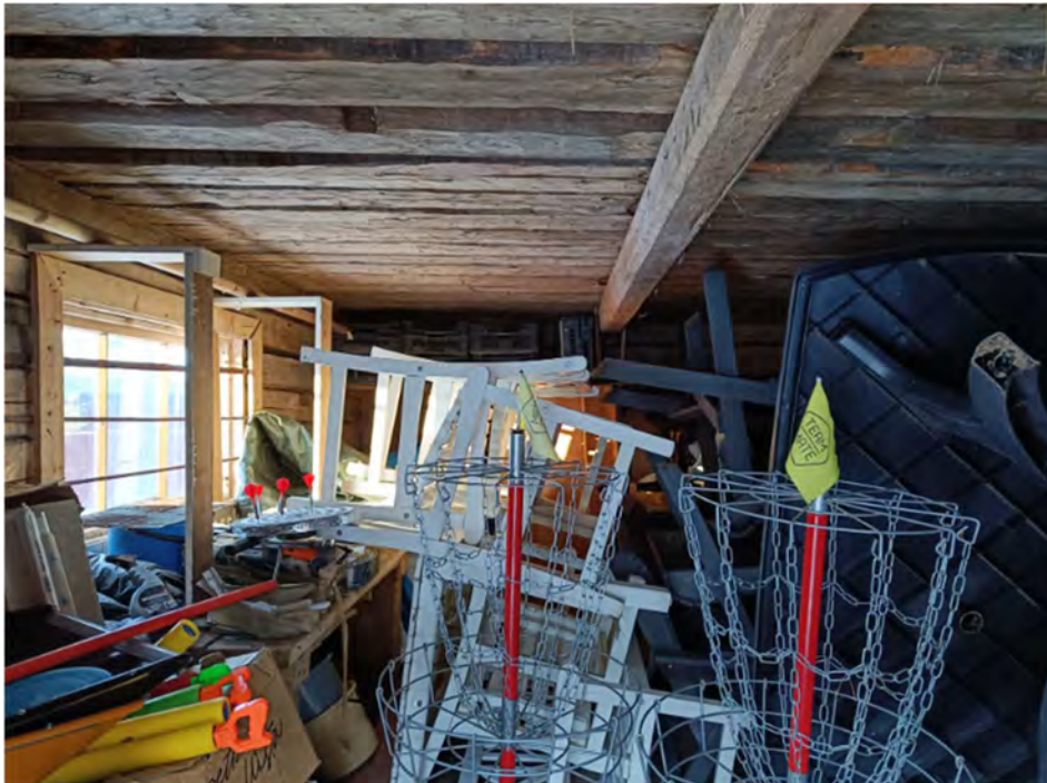
Kuva 25. Sisäkuva aitan ensimmäisestä kerroksesta.
