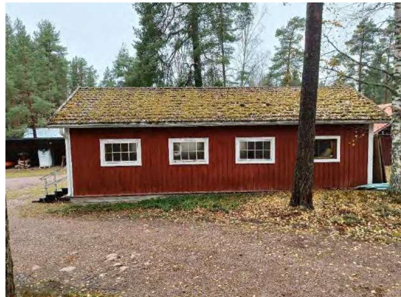
Kuva 22. Veistämön pitkä julkisivu, vastakkainen julkisivu on aukotukseltaan samanlainen.
