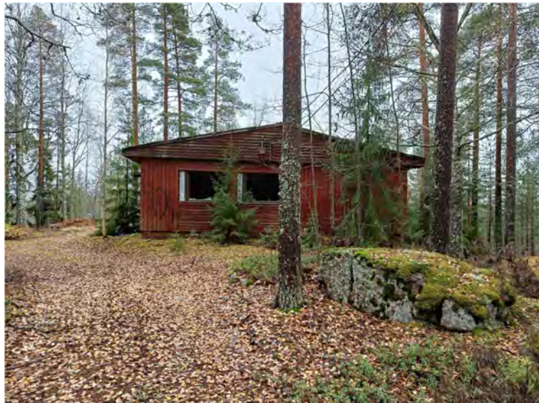
Kuva 50. Opettajien asuntolan pohjoisjulkisivua.
