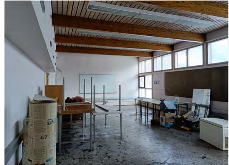
Kuva 54. Ensimmäisen kerroksen opetussali.
