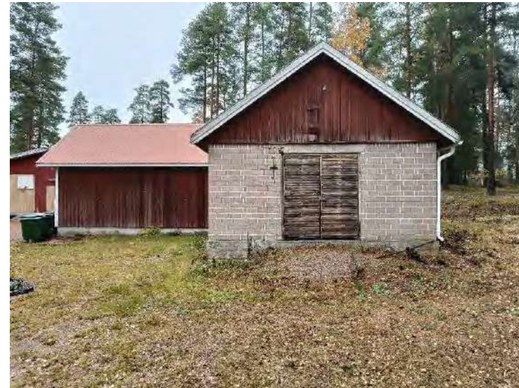
Kuva 36. Tinaverstaan eteläpääty. Vasemmalla puurakenteinen puuvararasto.
