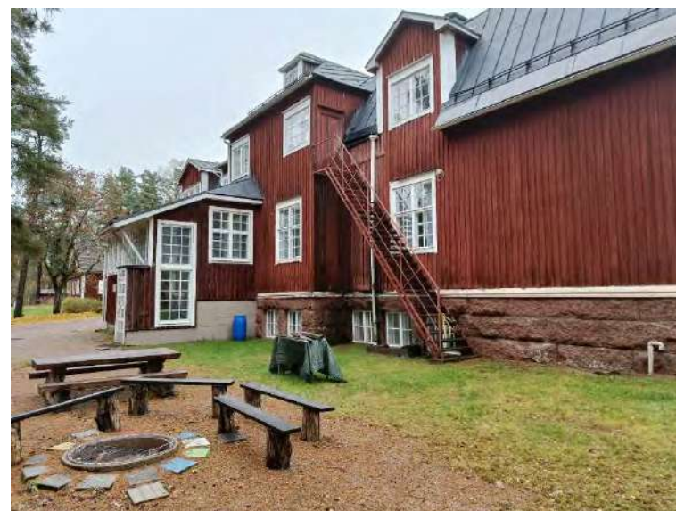
Kuva 12. Päärakennuksen takajulkisivua. Kuisti ja palopoistumisportaat on rakennettu jälkikäteen.
